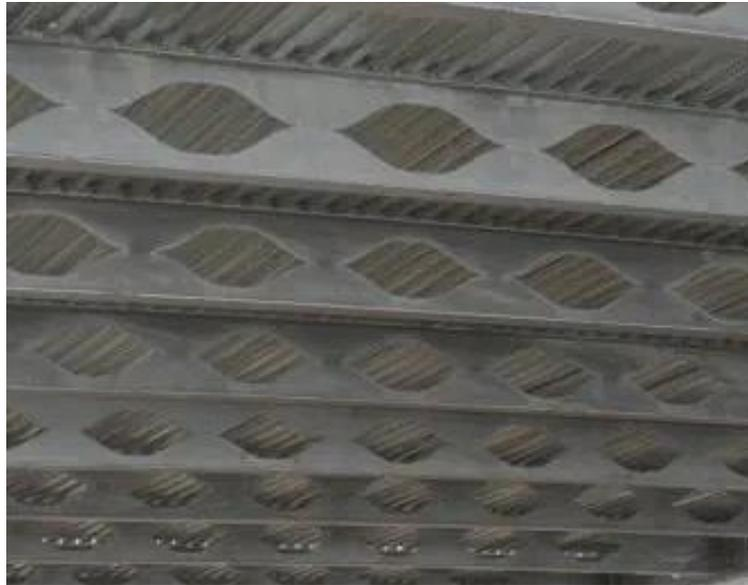
Figura 2.9 – Viga em aço Angelina (alveolar) – Arcelor-Mittal (Constructalia, 2016)
