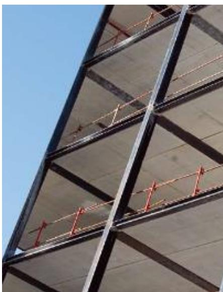
Figura 2.15 – Recurso a painéis pré-fabricados de betão (Arcelor-Mittal, 2014b)
