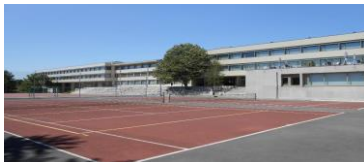
Figura 3. Espaço Exterior (E1 e E2).
