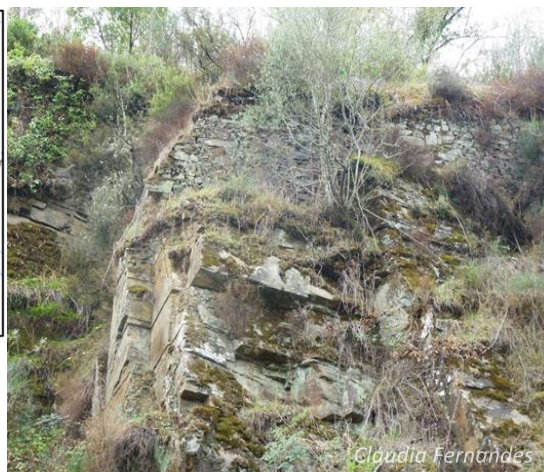
Figura 9.7 – Muros de pedra seca construídos sobre escarpa de xisto e ocupados por vegetação.
