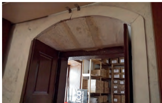
Fig. 11 – Interior da porta de serventia da torre, já com a nova divisão adossada à face norte.
