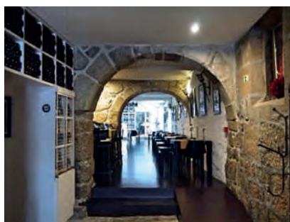
Fig. 6 – Os arcos do corpo construído por Gaspar Lopes de Carvalho, lançados sobre antiga viela. À direita, em primeiro plano, janela de uma casa anterior da judiaria.
