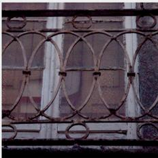
ANO. 08 - OXIDAÇÃO DE ELEMENTOS METÁLICOS (GUARDACORPOS)
