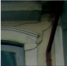
ANO. 01 - FISSURA DE ASSENTAMENTO NA PAREDE INCLUINDO LANCIL DE OMBREIRA
