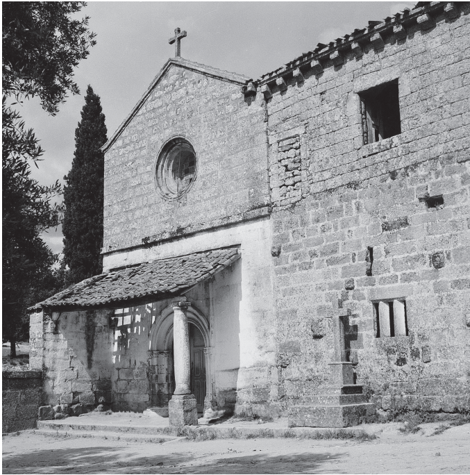
Fig. 5 Aspetto geral da fachada principal da igreja e conventinho de Santa Maria de Cárquere segundo o arquiteto Alberto da Silva Bessa (1949) Fonte: PT DGPC/SIPA FOTO.0081235, Alberto da Silva Bessa, 17 junho 1949
