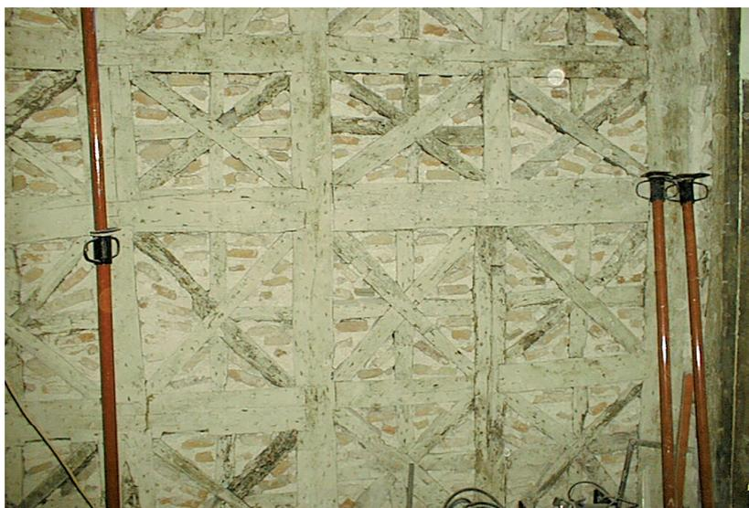
Figura 1.2- Guimarães. Parede interior de casa em tabique com estrutura em cruz, e enchimento com tijolo e argamassa.
