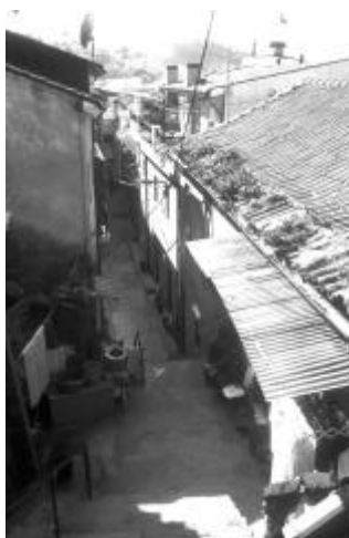
Figura 3-15. Rua da Creche
