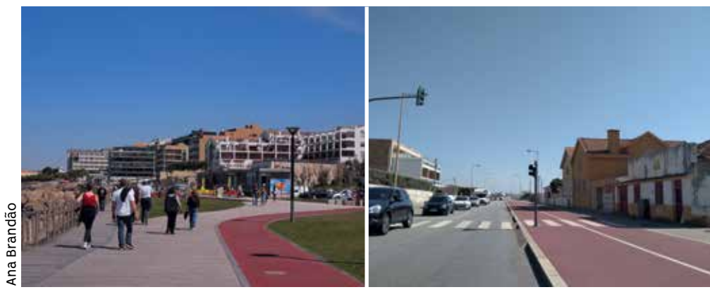
A intervenção na marginal atlântica não se articula de igual forma com os vários tecidos urbanos que atravessa. Praia das Pedras Amarelas, Valadares, Vila Nova de Gaia
