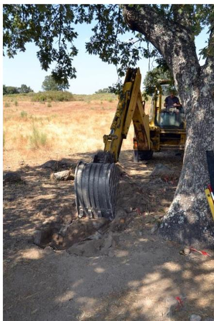
Figura 5 – Remoção das pedras, da terra e do geo-têxtil da área A, intervencionada inicialmente em 2011.
