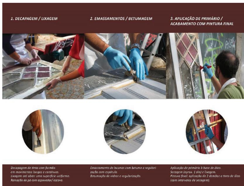
Figura 3: Manual de instruções para manutenção de janelas [7].
