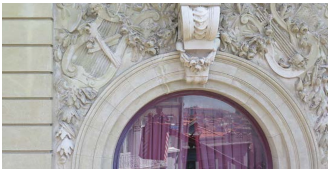
Figura I23 – Elementos decorativos que encimam as janelas da varanda das fachadas nascente e poente, 2019.
