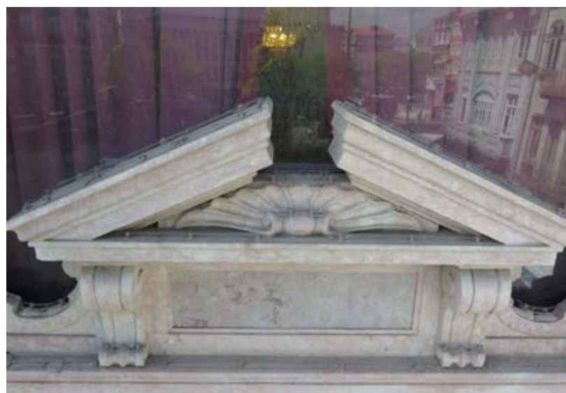
Figura 74 – Zona superior da janela, 2017.
