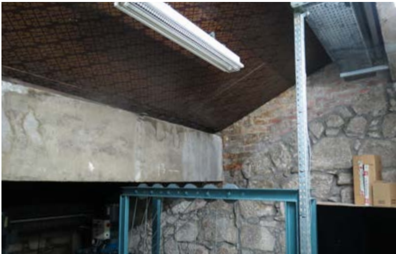
Figura 97 – Pormenor de transição de material acima do apoio da viga de betão, 2013.
