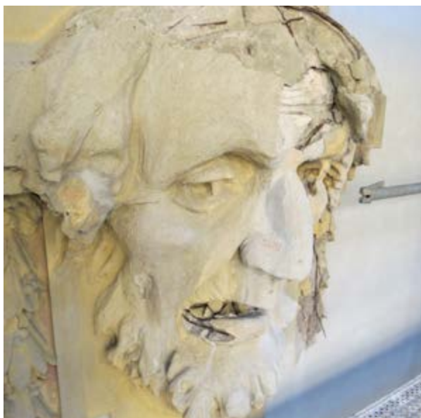
Figura I65 – Estado de degradação da “carranca de teste”, 2013.
