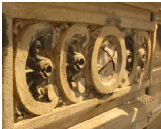
Figura 143 – Armaduras na zona da bola central, 2013.
