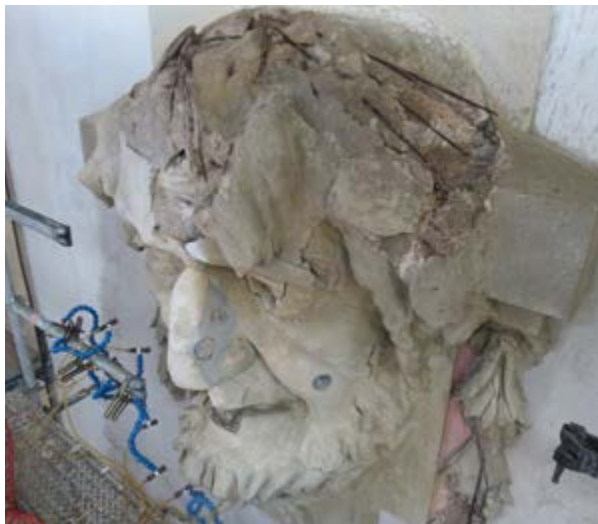
Figura I67 – Extração de carote ao nível da face e teste de arrancamento de argamassa no nariz, 2013.
