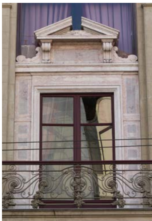
Figura 73 – Janela de mármore, 2019.
