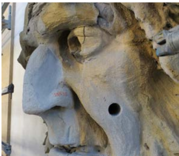
Figura I66 – Extração de carote ao nível da face e teste de aderência de argamassa no nariz, 2013.
