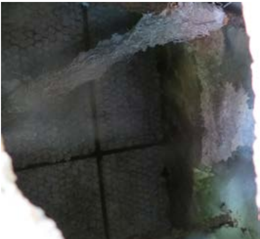
Figura 92 – Pormenor das lajetas com varão metálico e rede de galinheiro, e varões a travar a cornija à parede, 2013.
