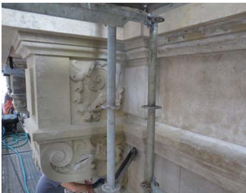
Figura 76 – Elementos decorativos com varões metálicos integrados, 2013.
