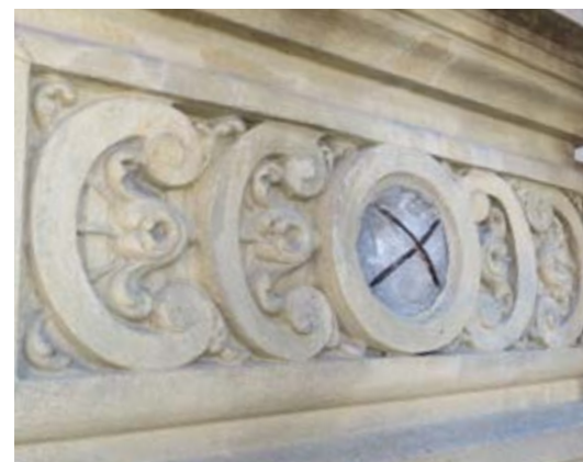
Figura 144 – Armaduras na zona da bola central, 2013.
