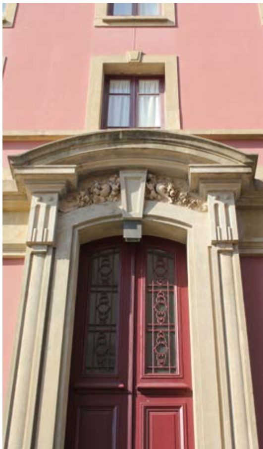
Figura 153 – Remate da porta da fachada sul, 2019.
