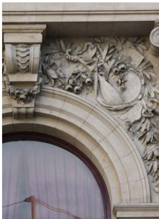
Figura 69 – Vista geral do elemento, 2019.
