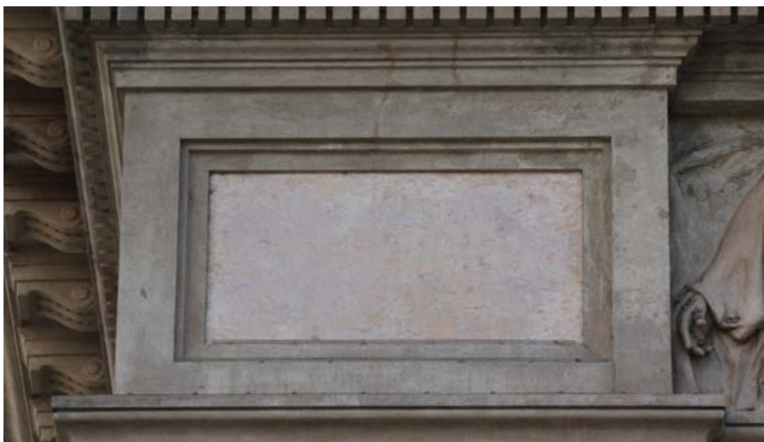
Figura 30 – Painéis em mármore rosa negral, 2019.
