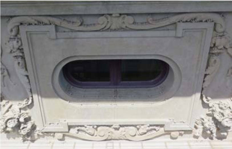
Figura I18 – Molduras e decorações de enquadramento de janelas, 2017.
