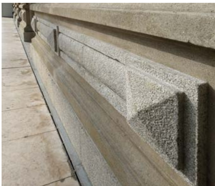
Figura 85 – Embasamento na fachada nascente, 2014.
