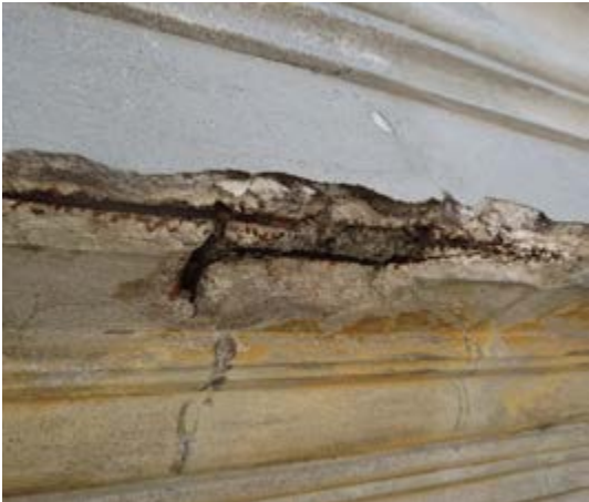
Figura 91 – Varões longitudinais e rede de galinheiro na execução da face inferior da cornija, 2013.
