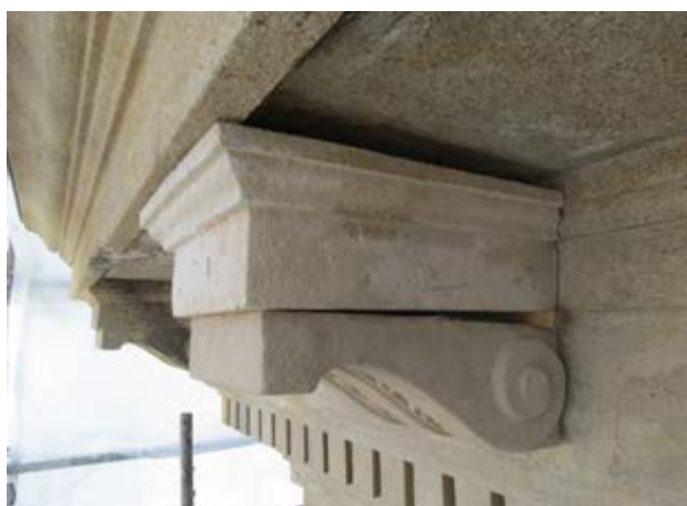
Figura 26 - Colocação de mísulas novas, 2014.
