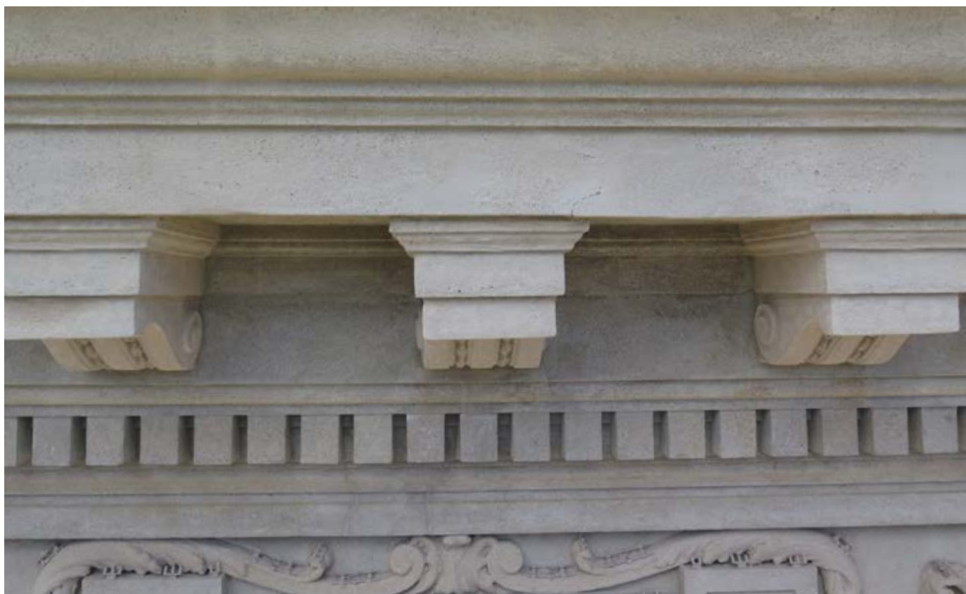
Figura 22 – Mísulas sob a cornija, 2017.
