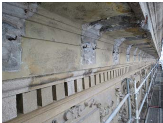
Figura 20 – Zona inferior da cornija após retirada das mísulas, 2013.
