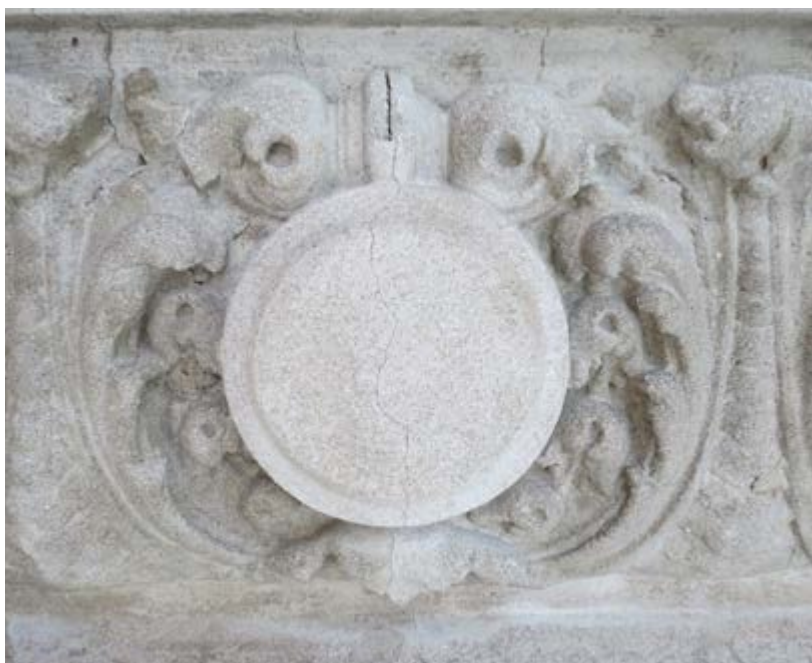
Figura 79 – Uma camada final de argamassa de recobrimento aparenta esconder a junta da peça, 2013.
