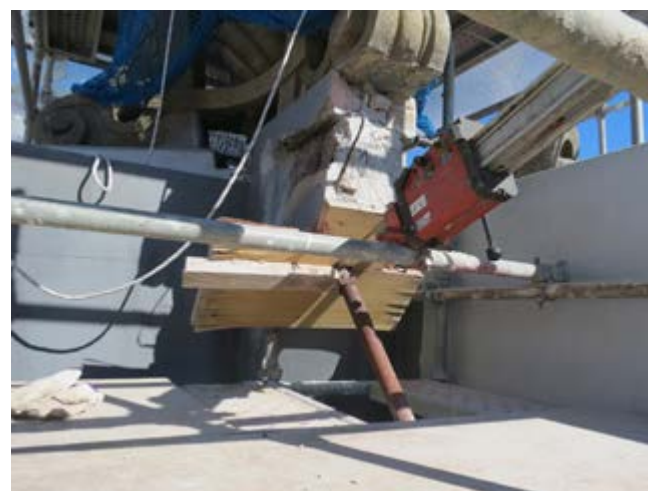
Figura 9 – Pregagem estrutural na viga em consola, 2013.
