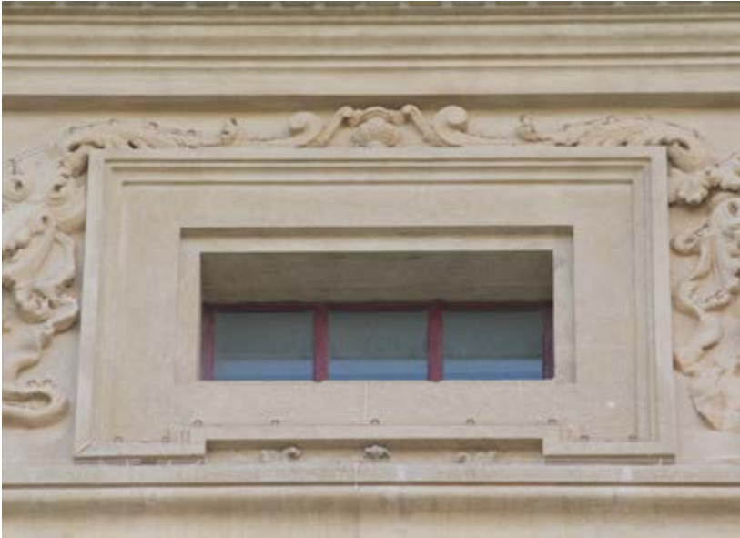
Figura I19 – Molduras e decorações de enquadramento de janelas, 2019.
