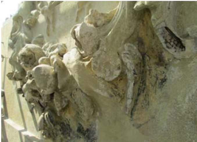
Figura II4 – Varão e rede de galinheiro na moldagem dos elementos, 2013.
