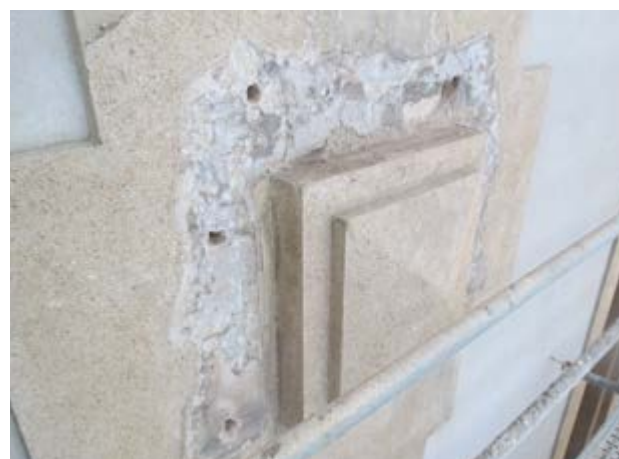
Figura I33 – Fachada após a remoção de elementos em mau estado, para reposição de réplicas. A base permite verificar que estes elementos foram pré-moldados e aplicados posteriormente nas fachadas, 2014.
