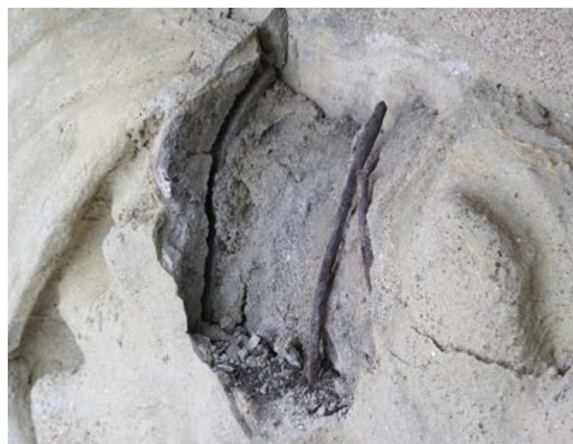
Figura 89 – Pormenor de execução do friso entre duas camadas de argamassa, 2013.
