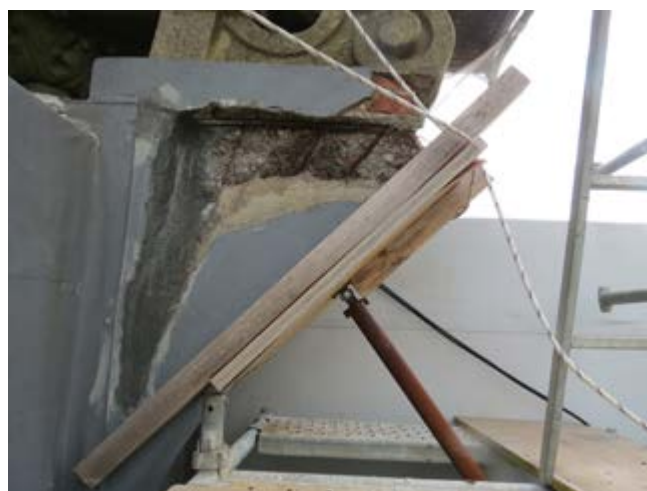
Figura 8 – Apoio pelo interior numa viga em consola, 2013.
