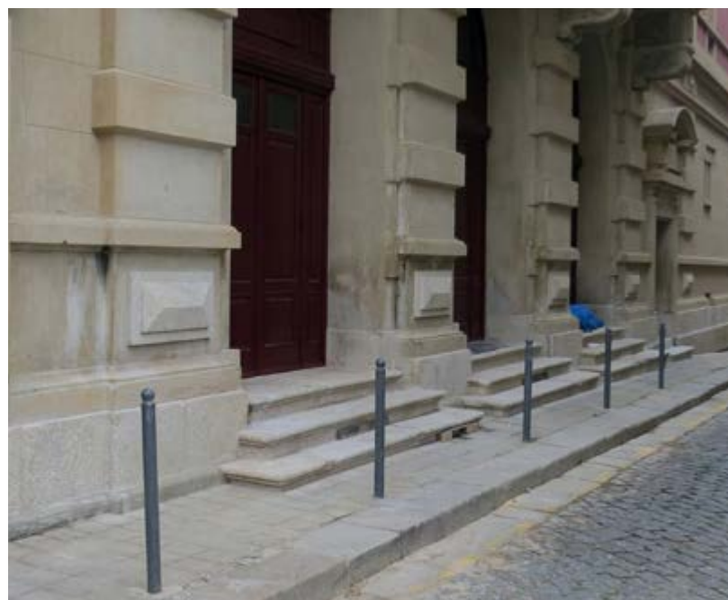
Figura 86 – Embutidos de granito nas portas da fachada nascente, 2014.
