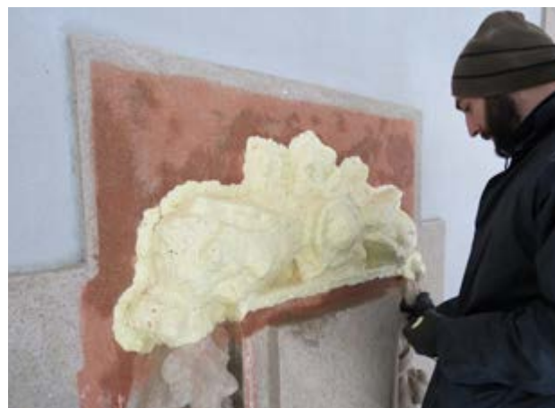
Figura I32 – Execução de moldes em elemento em bom estado, 2014.
