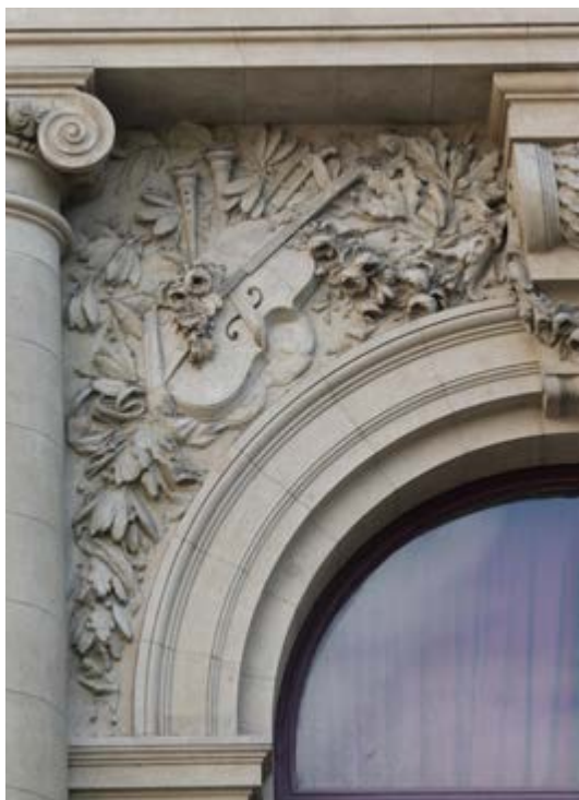
Figura 65 – Vista geral do elemento, 2017.
