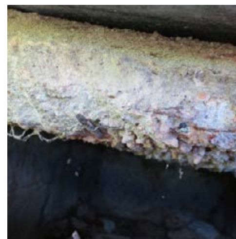
Figura 21 – Interior da cornija com granito da parede e elemento transversal em argamassa armada com rede de galinheiro, 2013.
