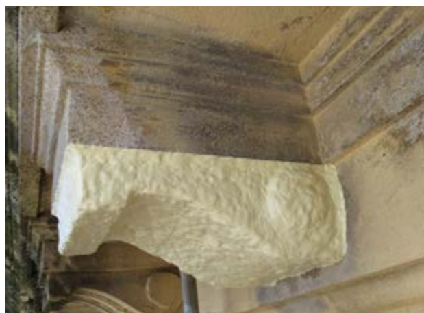
Figura 24 - Execução de molde da peça inferior da misula (peça com curvatura), 2014.
