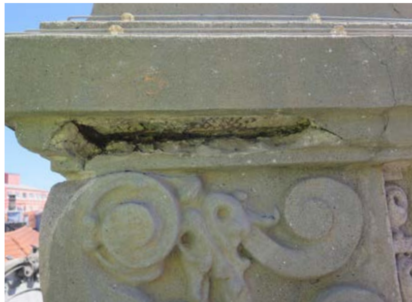
Figura I02 – Varões longitudinais e rede de galinheiro na execução do friso, 2017.
