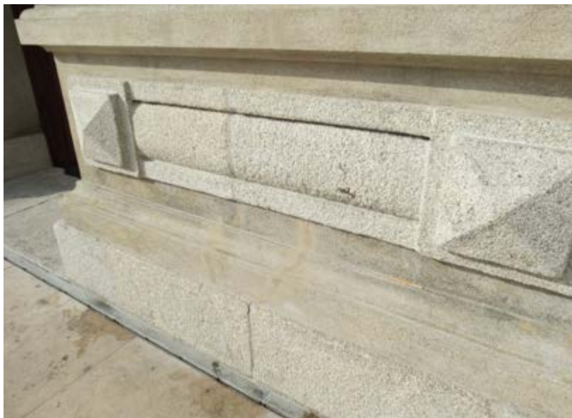
Figura 84 – Embutido de granito trabalhado no embasamento da fachada norte, 2014.
