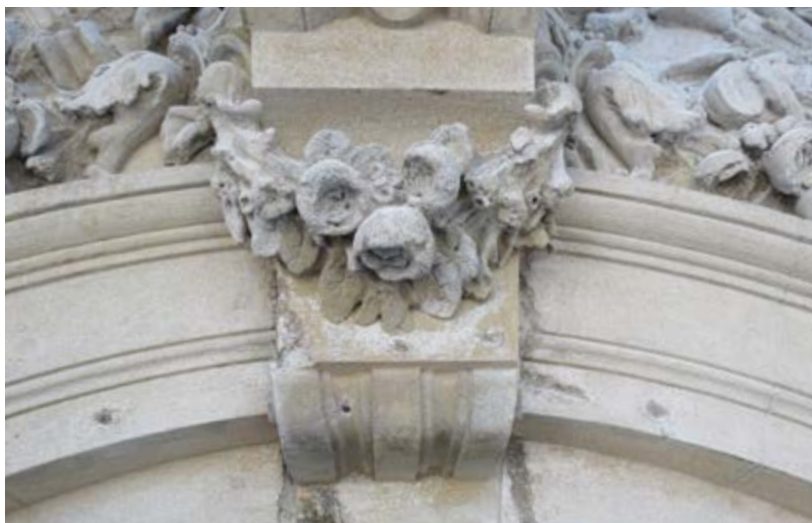
Figura 72 – Zona superior da janela, 2013.
