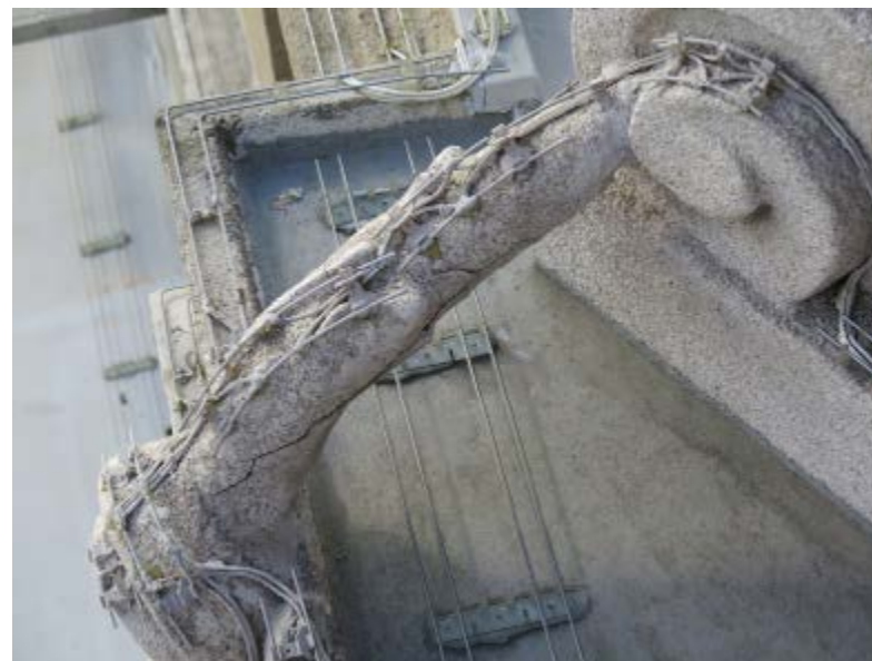
Figura 11 – Vista superior de elemento esbelto de ligação entre o festão e o vaso, 2017.
