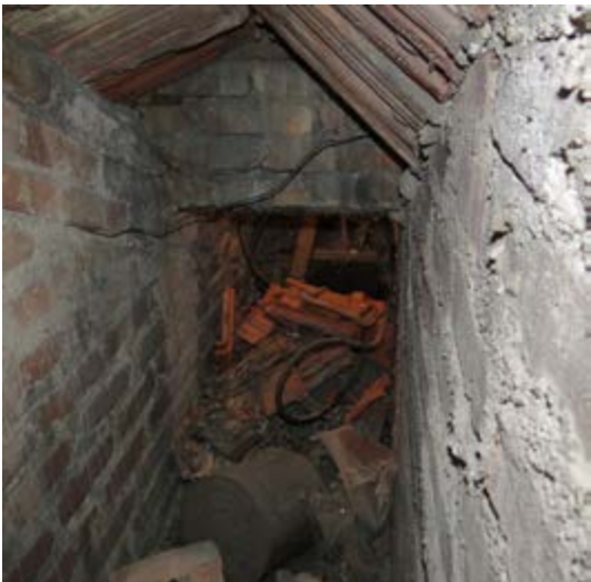
Figura 96 – Murete do corpo da teia (interior), 2013.
