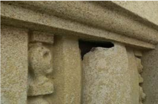
Figura 16 – Indício da aparente não existência de rede de galinheiro no volume oco do óvulo, pela observação de zona de rutura, 2013.
