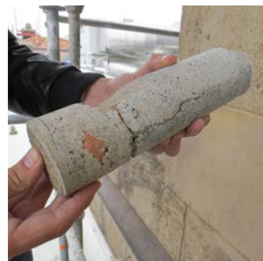
Figura 83 – Carote extraído em fachada lateral, que mostra uma camada de reboco com cerca de 12 cm sobre parede de granito, 2013.
