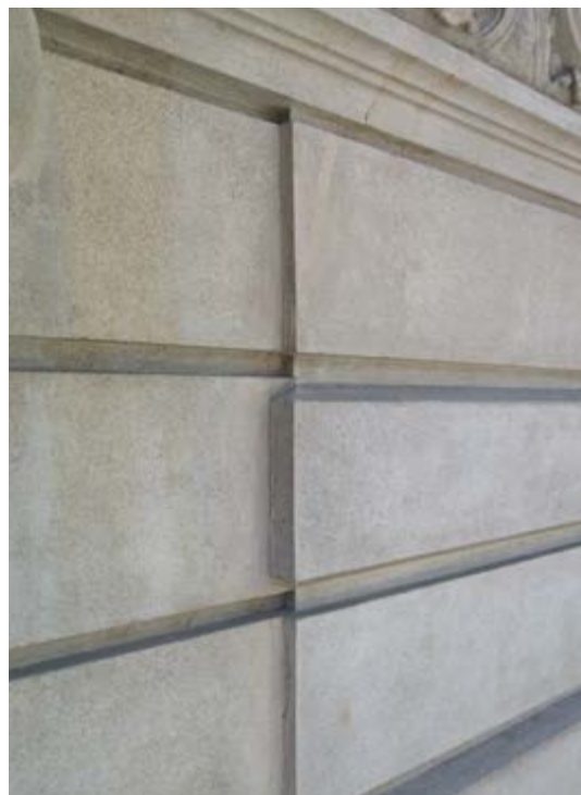
Figura 81 – Reboco em embasamento da fachada principal, 2019.
