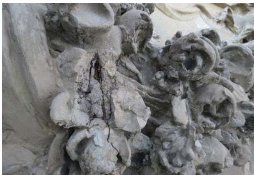
Figura I51 – Varões metálicos no festão, 2013.
