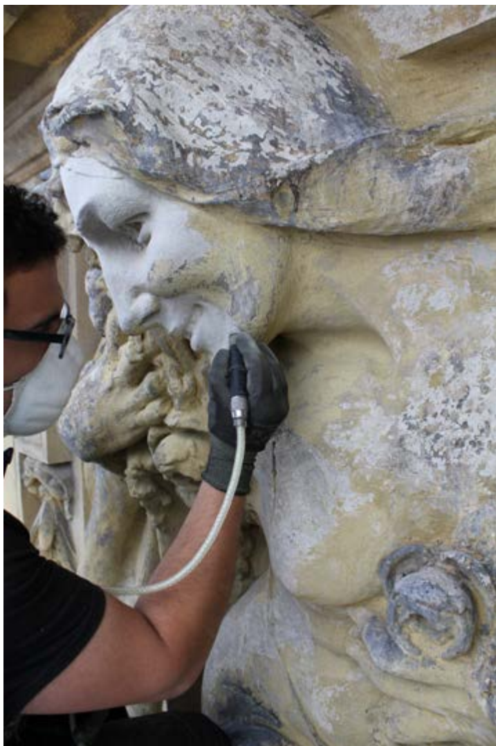
Figura 40 – Sondagem de limpeza com micromartelo, 2013.
