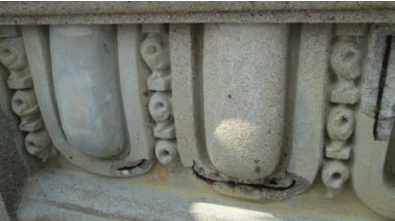
Figura 15 – Armadura no rebordo liso que contorna o óvulo, 2013.
