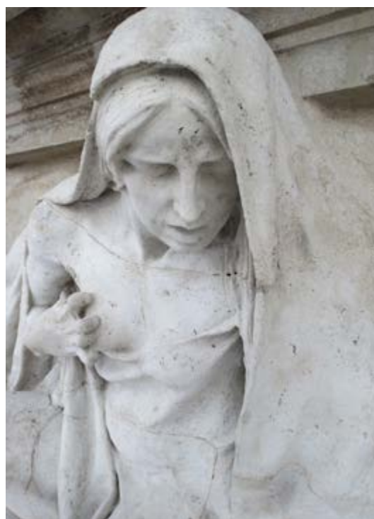
Figura 38 – Junta horizontal abaixo do pescoço, 2014.
