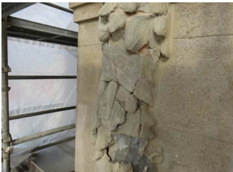
Figura 100 – Aparente modelação do elemento sobre enchimento de argamassa, 2014.
