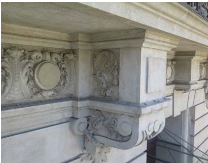
Figura 77 – Vista frontal das vigas cachorro, 2017.
