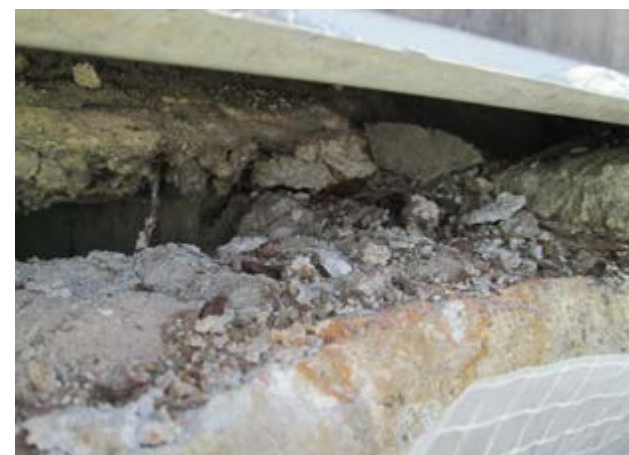
Figura 19 – Argamassa armada com rede de galinheiro e varões, 2013.
