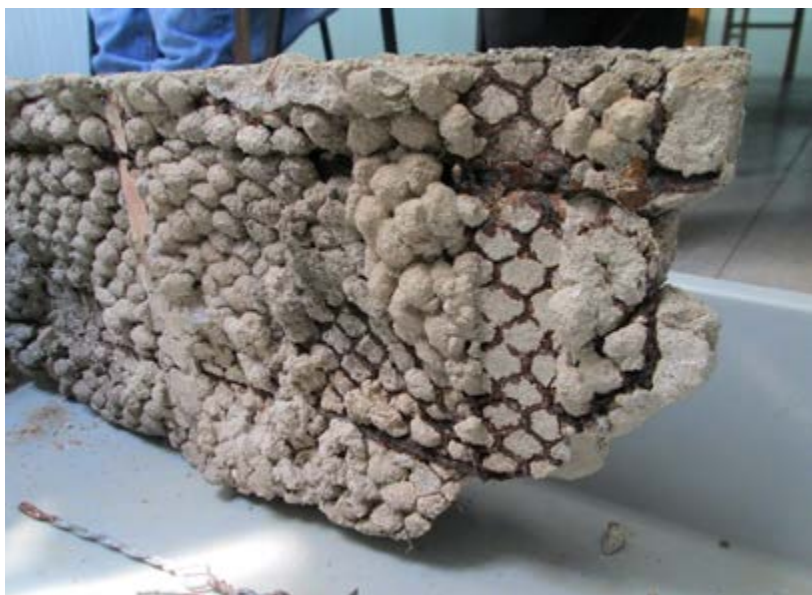
Figura 4 – Mísula original do Teatro São João e processo construtivo em volume oco com rede de galinheiro, varões metálicos e réguas de madeira, 2015.
