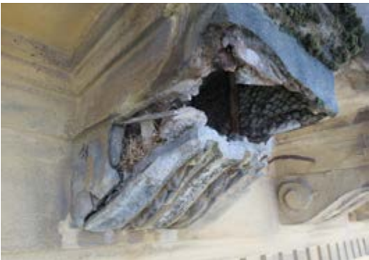
Figura 31 – Mísulas fingidas (volume oco), 2013.
