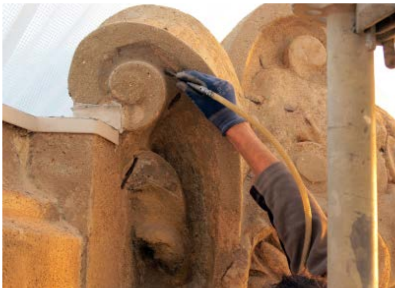
Figura 63 – Remoção dos produtos da oxidação de varões com micromartelo, 2014.
