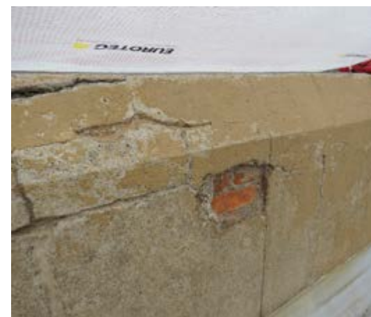
Figura 54 – Tijolo maciço no murete do corpo da teia, 2013.
