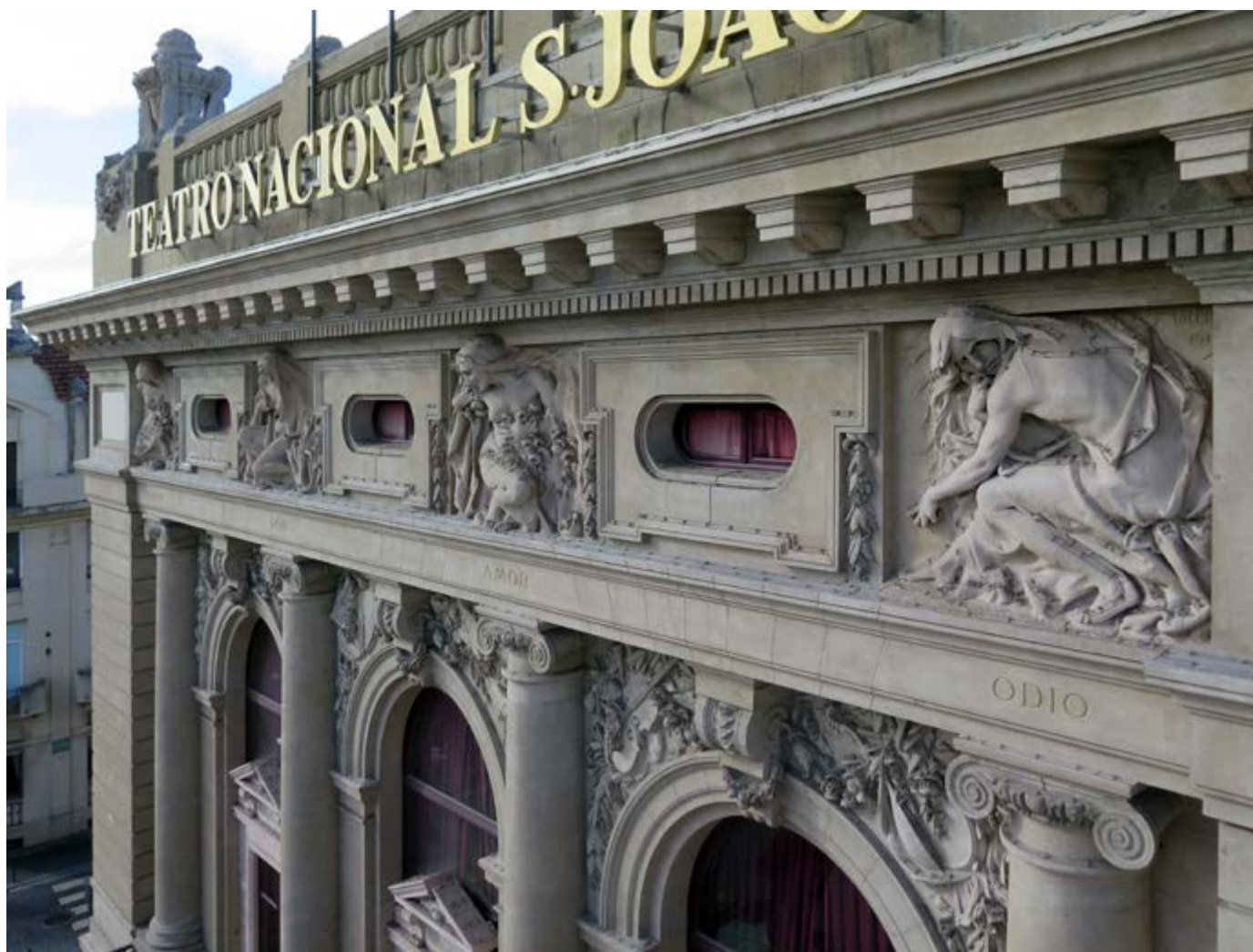
Figura 5 – Estátuas que encimam a fachada principal, 2019.
