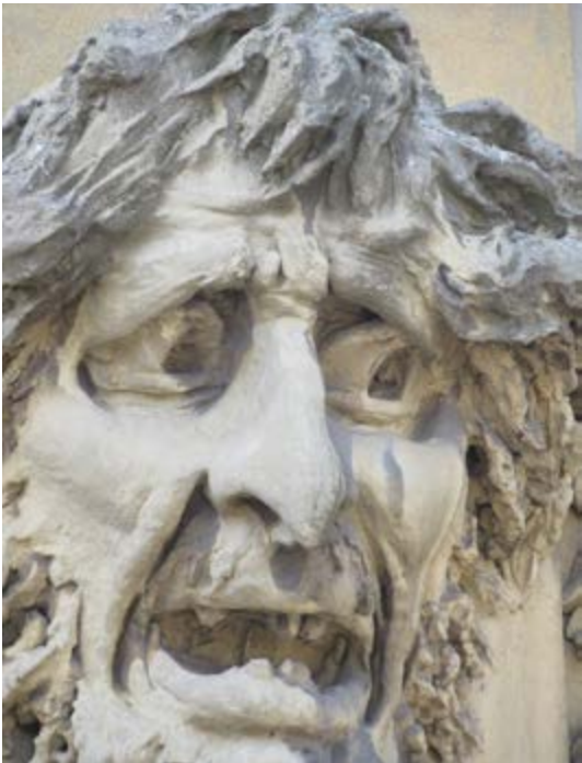
Figura 14 – Carranca da fachada lateral nascente, 2013.
