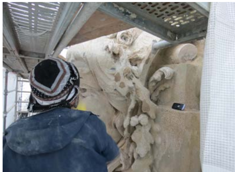
Figura 64 – Tratamento de varões e reposição de argamassas, 2013.
