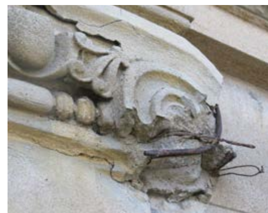
Figura 28 – Voluta de pilar com varões metálicos, 2013.
