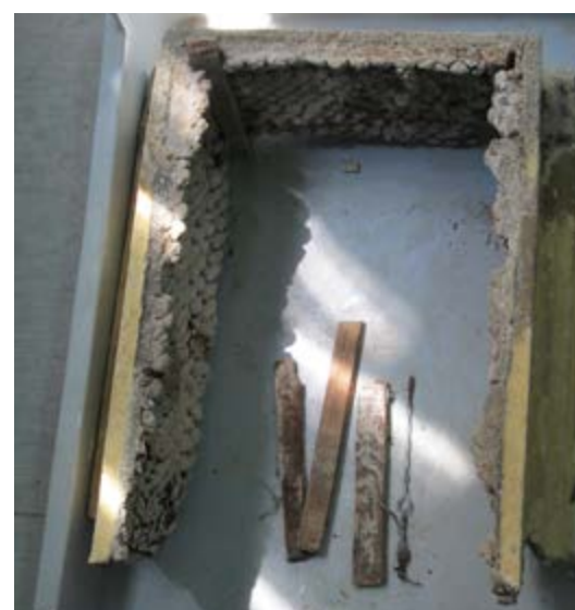
Figura 40 – “Gaveta” superior da mísula, reguado e arames de nivelamento, 2013.
