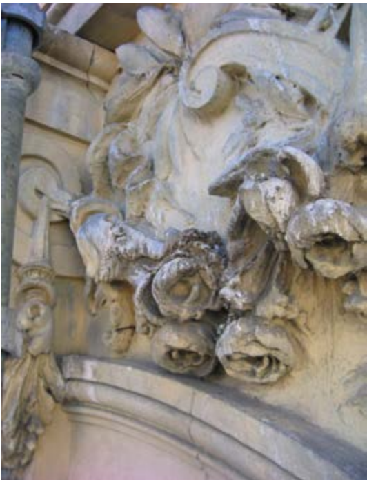
Figura 13 – Pormenor de flores na fachada lateral, 2009.
