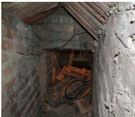
Figura 55 – Pormenor de zona oca do murete do corpo da teia, 2013.
