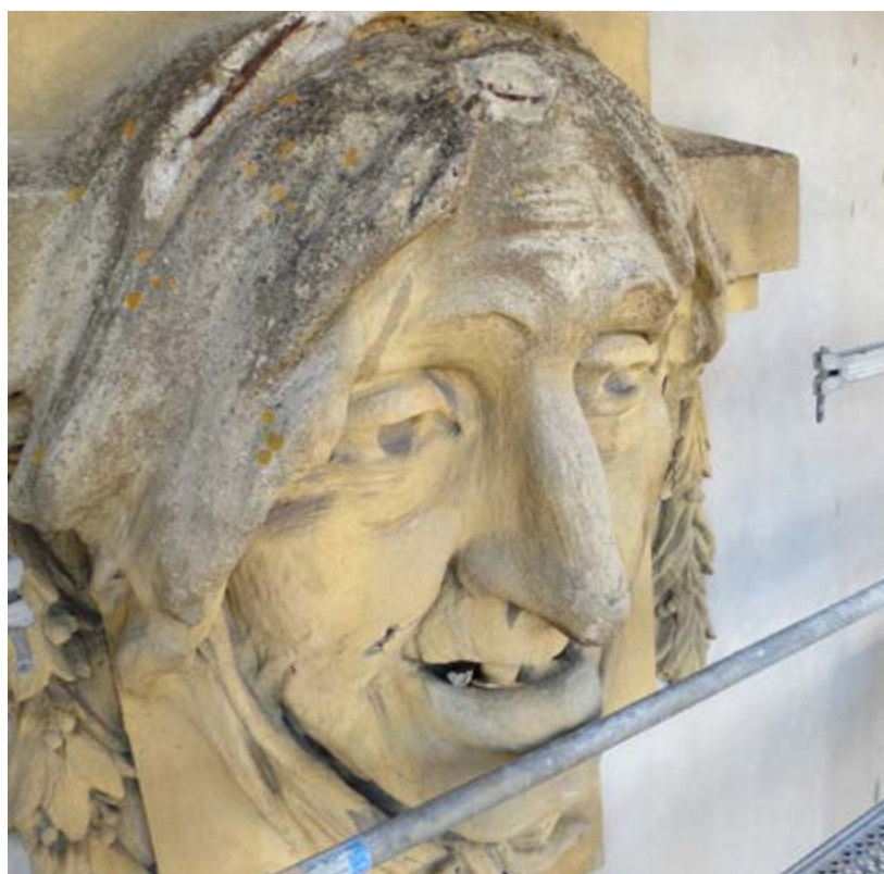
Figura 60 – Destacamento de betão na zona superior da cabeça, por corrosão de armaduras, 2013.
