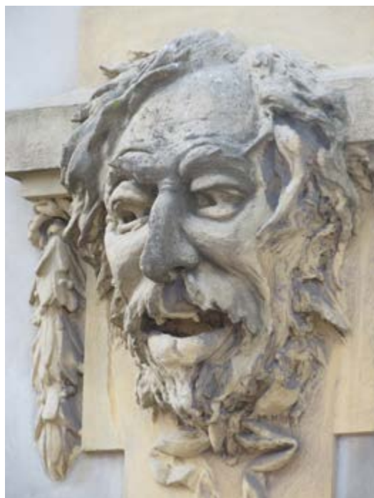
Figura 16 – Carranca da fachada lateral nascente, 2013.
