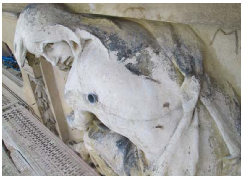
Figura 46 – Junta horizontal na estátua Ódio . Tamponamento do local de extração do carote, 2013.
