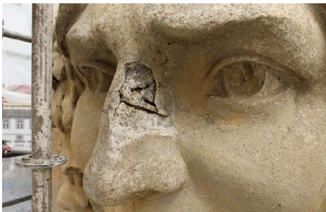
Figura 26 – Varões metálicos em nariz de escultura, 2013.
