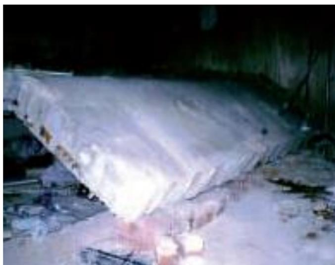
Figura 4 - Queda de laje a demolir [7].
