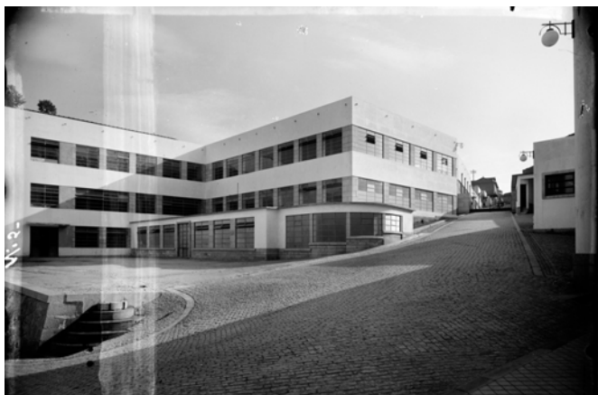
Fig. 4 Panorâmica do portão e entrada da fábrica. [Centro Português de Fotografia, PT/CPF/ ALV/015059].
