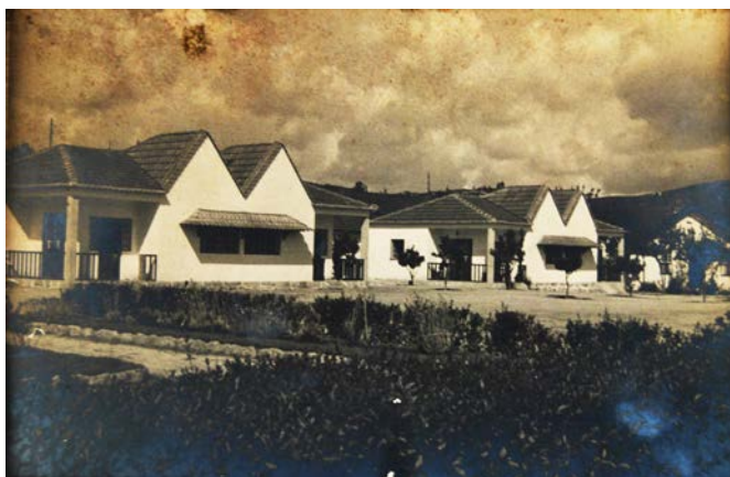
Fig. 12 Bairro de Antime (c. 1930). [Arquivo privado – Fábrica de Fiação e Tecidos de Fafe].
