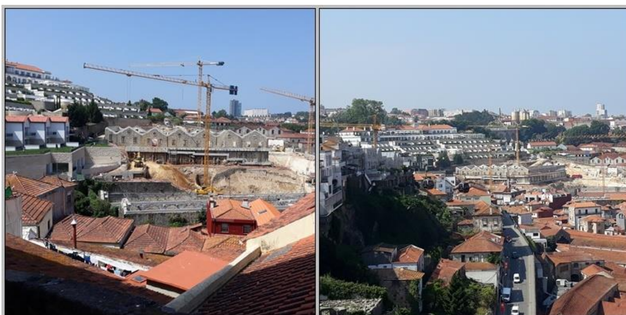
Figura 6 - Construção do futuro “Museu do Vinho” em 2018. Elaboração própria.
