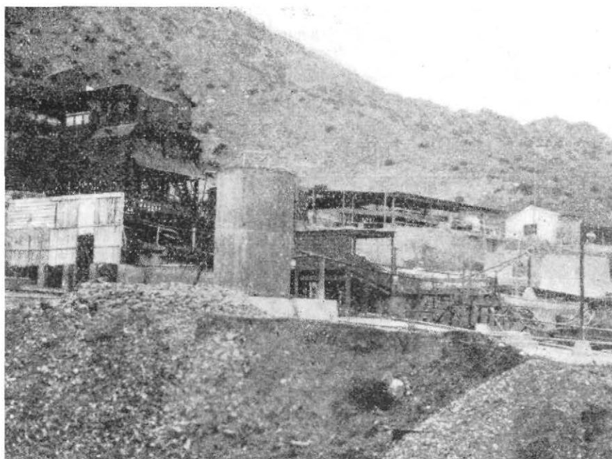
Figura 3. Zona de tolvas, trituración y molienda, de la planta Dorr (año 1935).
