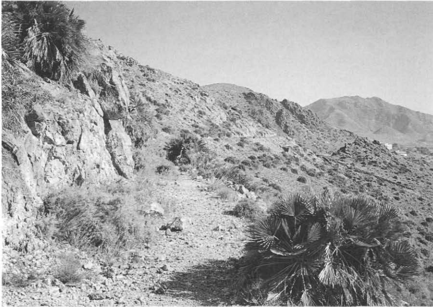
Figura 6. Restos de la red de transporte de mineral aurífero construida por Adaro para conectar la mina "Las Niñas" y la planta "Dorr" de cianuración, en la década de los años cuarenta. Este tramo se construyó en la roca de la ladera del cerro y es el tramo más elevado de los dos que constituyen la citada red. En este camino, es donde estaban instalados los railes sobre los que se desplazaban las vagonetas con el mineral aurífero. Al final de este tramo, (al fondo de la imagen), es donde está el plano inclinado por el que bajaban las vagonetas hasta el segundo tramo que constituía la red de transporte y que se encuentra a una menor altura topográfica.
