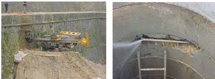
Figura 14 – Realização das ancoragens
