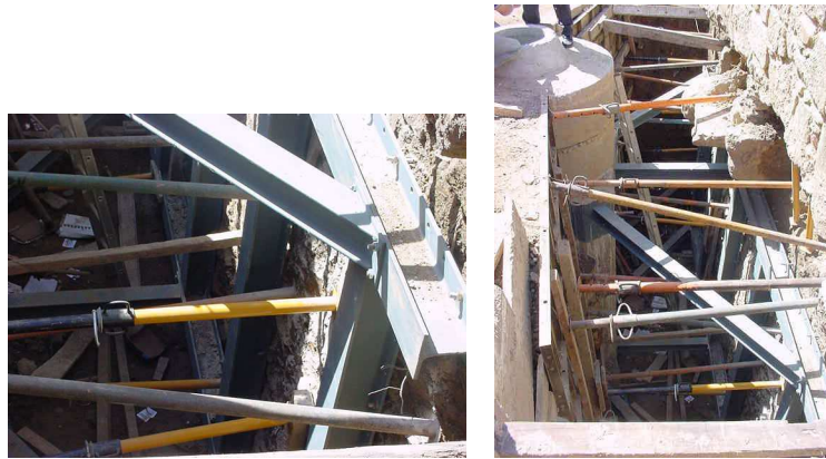
Figura 11 – Ligação da muralha ao poço em dois níveis
