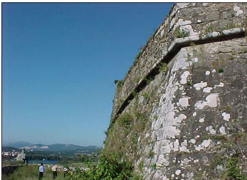
Figura 2 - Castelo de Valença. Troço de muralha
