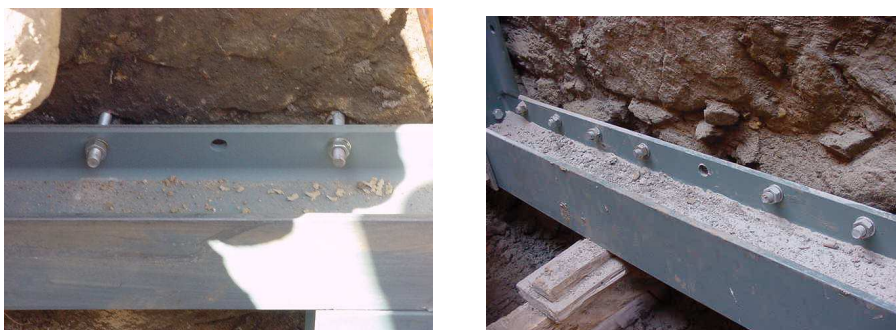
Figura 12 – Ligação, através de buchas químicas da muralha aos perfis
