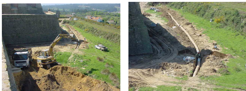
Figura 15 – Ligação da caixa de visita à rede de águas pluviais
