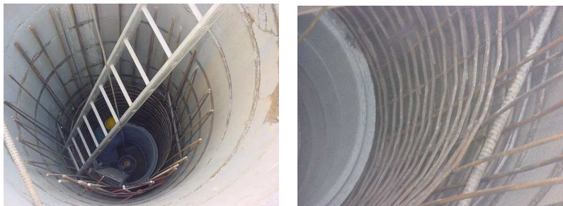
Figura 9 – Realização da parede de betão armado dentro das duas argolas
