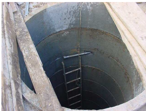
Figura 8 – Execução do poço
