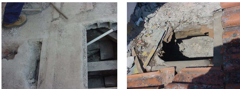
Figura 25 – Prospecção na zona da viga V2 (lado Poente).
