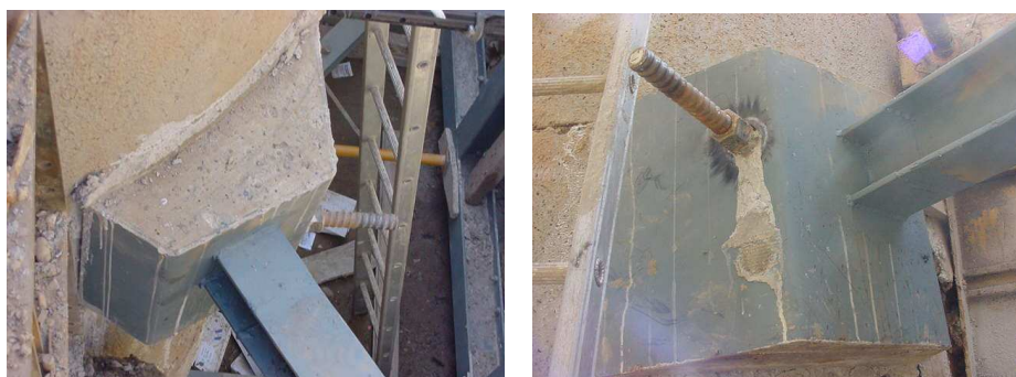
Figura 13 – Viga de reforço para ancoragem das ligações
