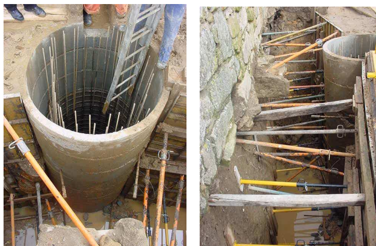
Figura 10 – Aspectos da realização da parede de betão armado dentro das duas argolas
