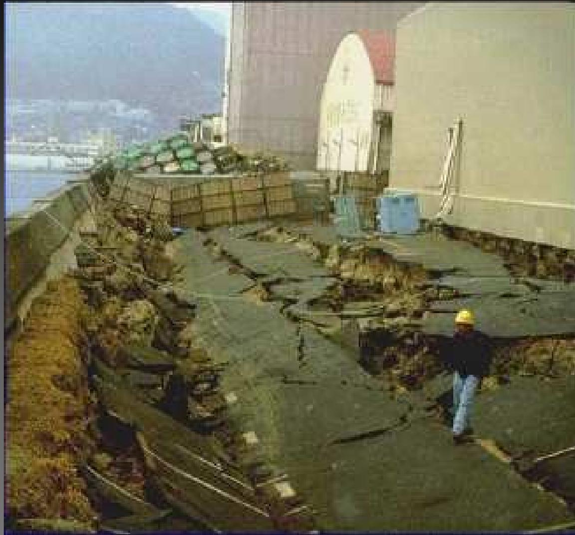
Liquefacção do solo junto a uma estrutura de contenção da Great Bridge (EUA, 1998)
