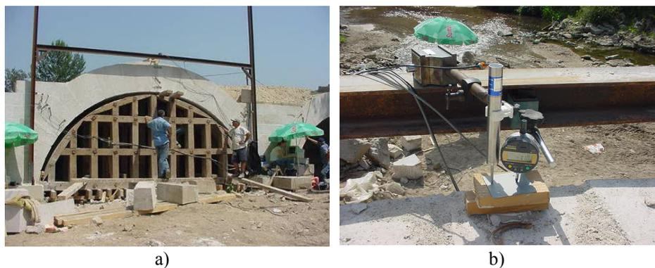
Figura 14: Descimbre de um arco. (a) Pórtico de referência para LVDT's e comparadores e (b) seu posicionamento no coroamento do arco.
