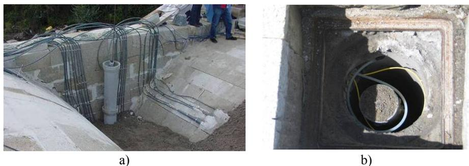
Figura 17: Colunas de apoio aos sensores de pressão. (a) Vista geral na fase de construção e (b) vista superior pela caixa de acesso.
