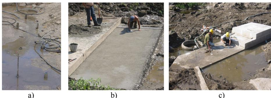
Figura 10: Fundações e pilares: (a) micro-estacas, (b) maciço de encabeçamento e (c) base de um pilar
