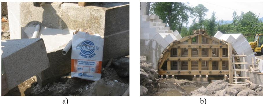
Figura 11: a) Pilar e b) arco em construção.
