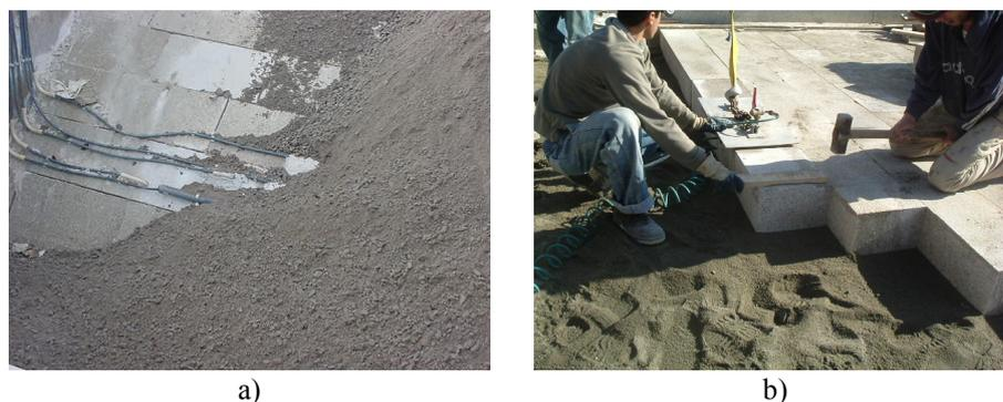
Figura 12: a) Enchimento com *tout-venant* e b) assentamento do lajeado de granito
