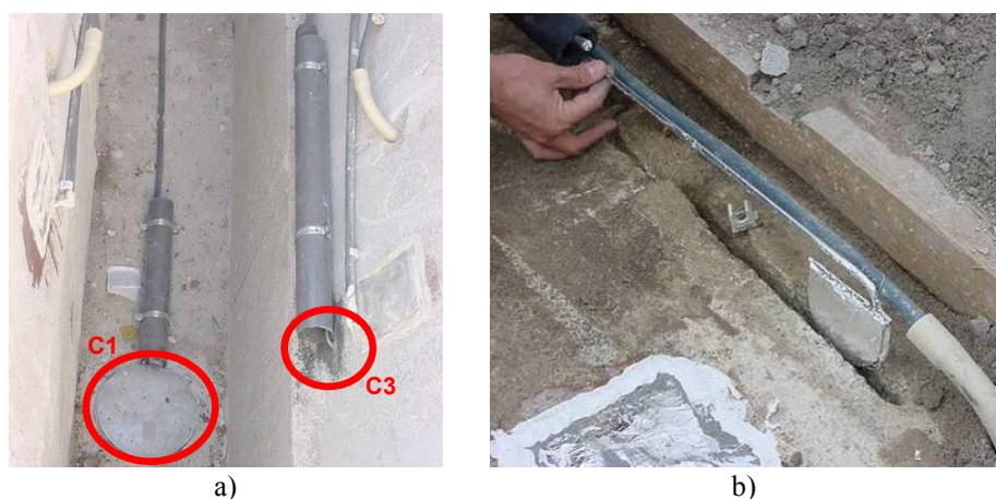
Figura 26: Células de pressão. (a) C1 e C3 já instaladas e (b) C7 em fase de instalação
