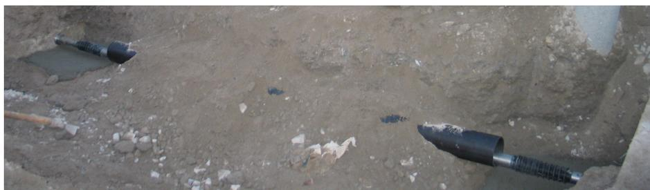
Figura 20: Sensores longos transversais. Aspecto geral e tubos de protecção.
