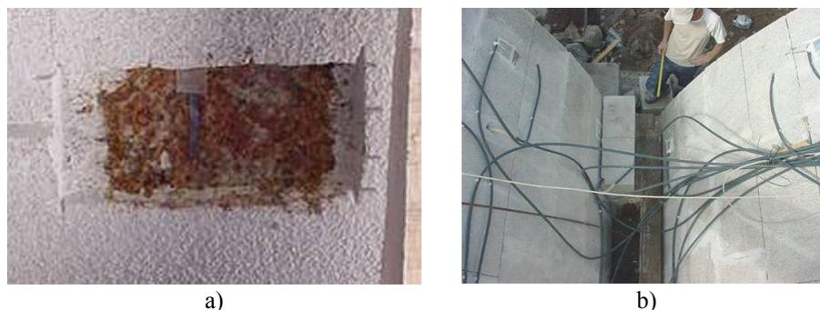
Figura 23: Colocação de extensómetros. (a) Regularização de base para extensómetro colado em cavidade previamente aberta e (b) protecção final.
