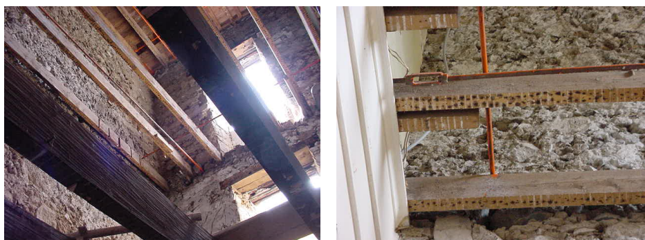
Figura 18: Utilização de tirantes para ligar paredes.
