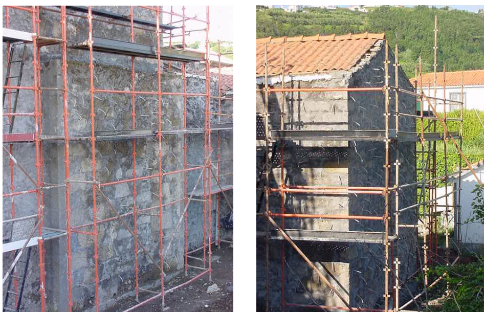
Figura 31: Injeção em paredes de alvenaria de pedra.
