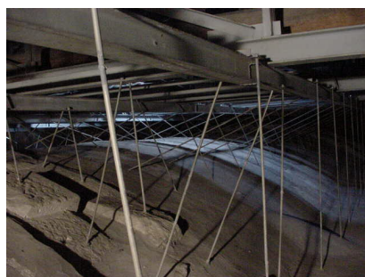
Figura 21: Reforço dos arcos e atirantamento dos contrafortes (Igreja do Bonfim – Projecto do Prof. J. Sarmiento).
