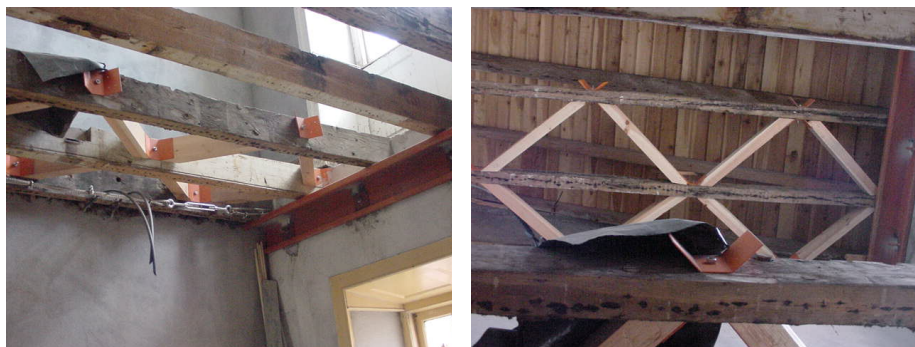
Figura 28: Apoios das paredes ao longo da sua altura [10].
