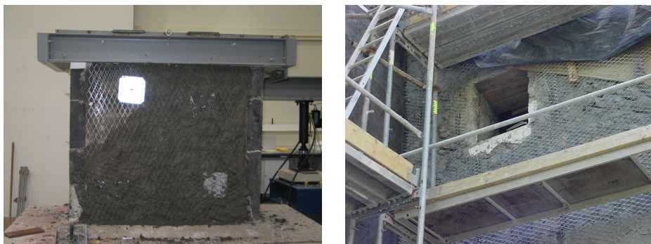
Figura 30: Reforço de paredes de alvenaria com malha de aço inox [15].
