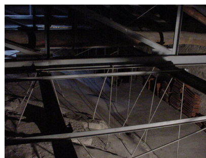
Figura 21: Reforço dos arcos e atirantamento dos contrafortes (Igreja do Bonfim – Projecto do Prof. J. Sarmiento).
