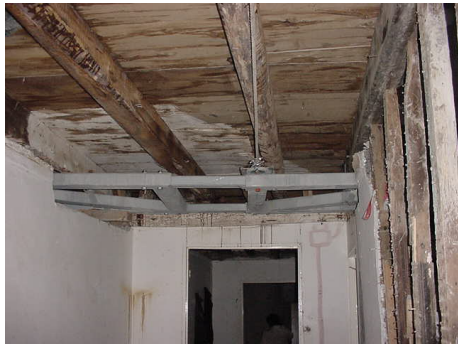
Figura 22: Estrutura metálica para assegurar a ligação entre todas as paredes da construção.
