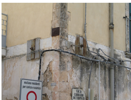
Figura 19: Utilização de tirantes para ligar paredes.
