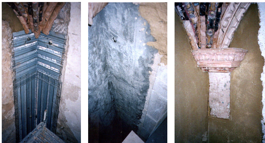
Figura 25: Esquemas de ligação entre paredes [24].
