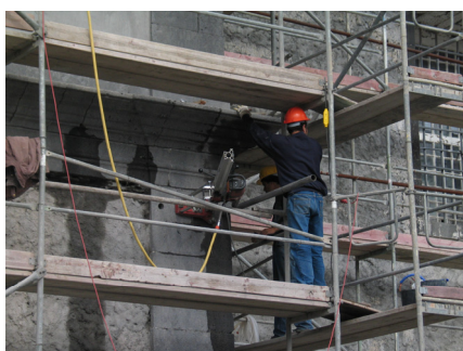
Figura 20: Utilização de tirantes para ligar paredes.
