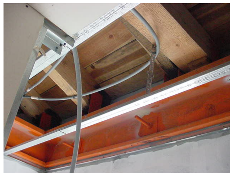
Figura 23: Cantoneira usada em toda a envolvente da construção para assegurar a ligação entre todas as paredes [20].
