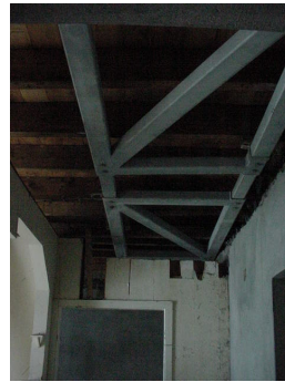
Figura 22: Estrutura metálica para assegurar a ligação entre todas as paredes da construção.
