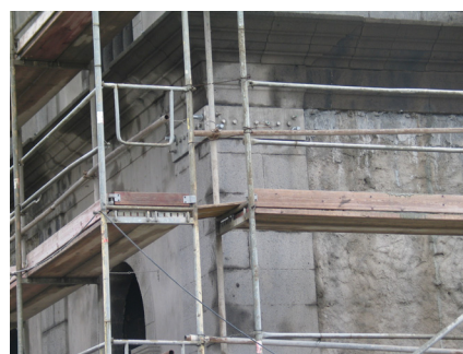
Figura 20: Utilização de tirantes para ligar paredes.
