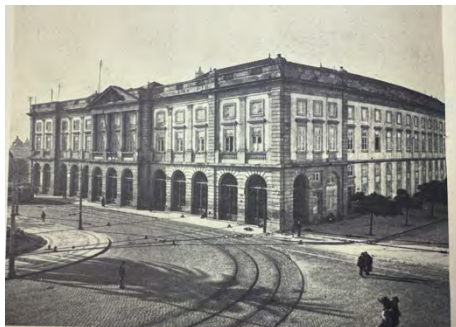
Figura 43 - Edifício da Reitoria da Universidade do Porto visto a partir da Praça de Gomes Teixeira (antiga Praça da Universidade), Porto, cerca de 1930. (AHMP)
