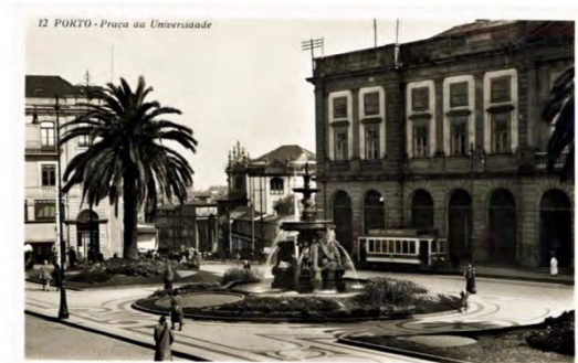
Figura 44 - Vista histórica da Praça de Gomes Teixeira (antiga Praça da Universidade), Porto, aproximadamente década de 1950. (AHMP)
