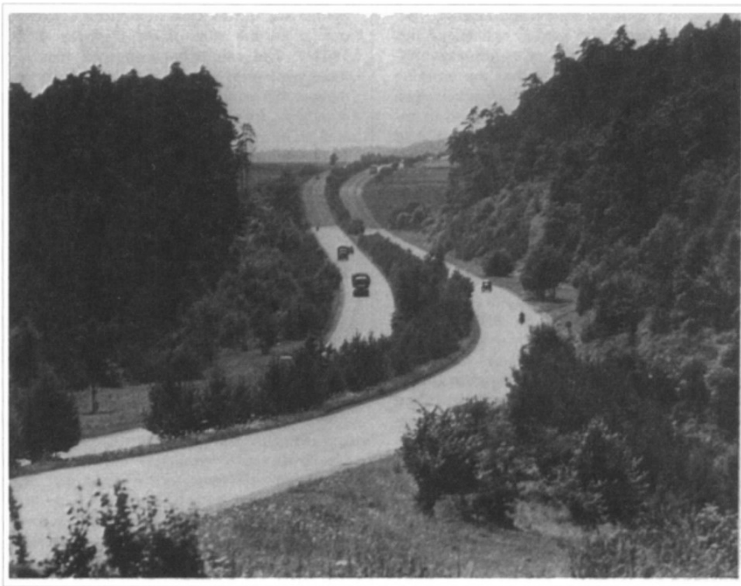
Fig. 11 - Secção da Autobahn entre Frankfurt e Kassel, mostra as curvas que acompanham o terreno e a plantação de espécies nativas no separador central. Crowe – The Landscape of Roads , 1960: figura 72 | fonte: Imbert (2020)
