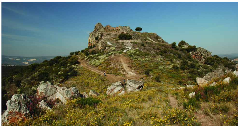
Fig. 3. Vista geral da área leste do Crasto de Palheiros, Talude Exterior Leste (atravessado lateralmente por passadiço serpenteante) e plataforma adjacente na zona das árvores (Plataforma Inferior Leste)
