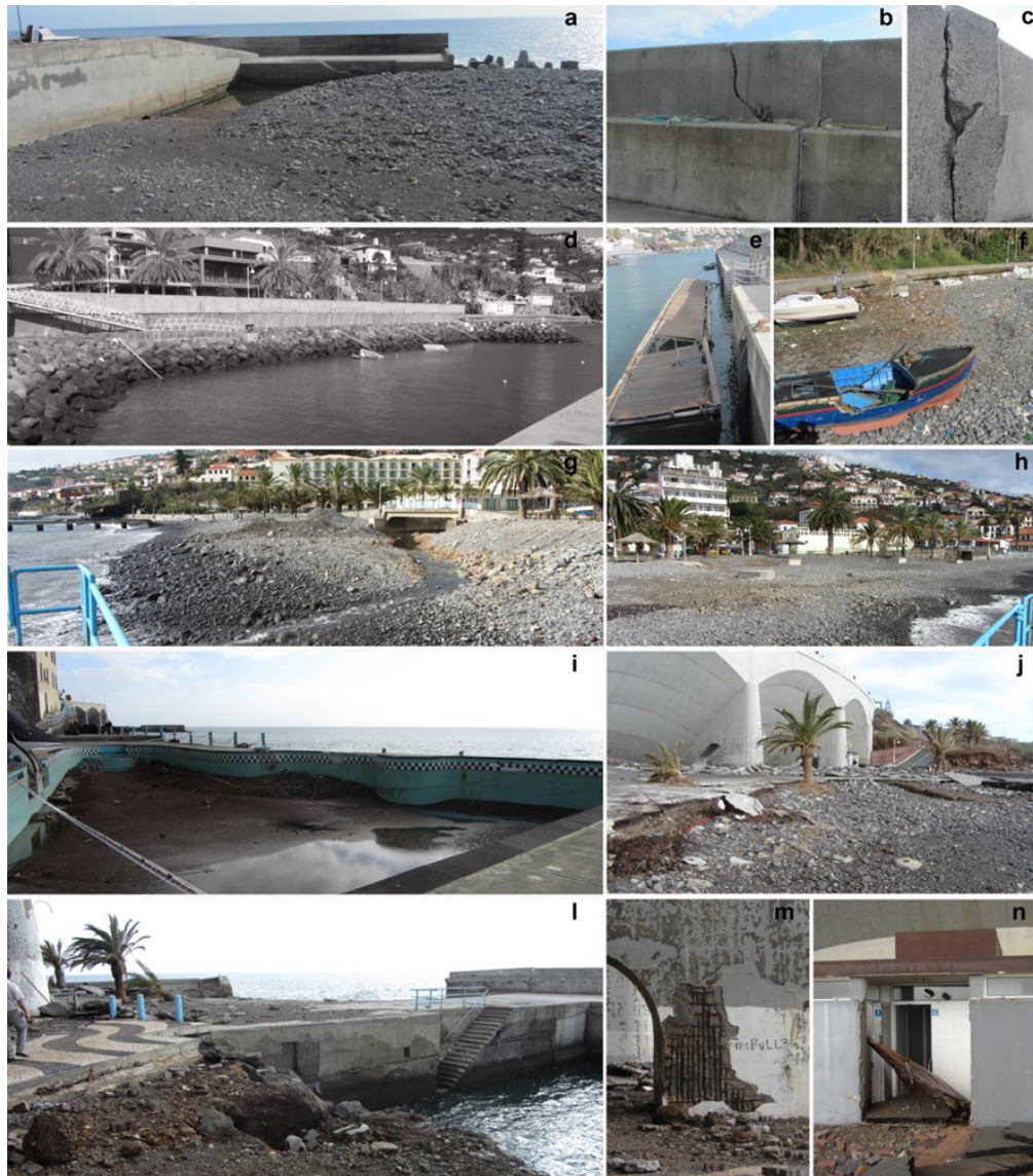
Fig. 6. Consequências do galgamento costeiro de 10/11-12-2013 registados na frente costeira da cidade de Santa Cruz no dia 26-12-2013: a – acreção sedimentar na praia; b, c - fendas na infraestrutura do porto; d– destruição das plataformas flutuantes; e – ausência dos elementos do porto devido a sua destruição; f – depósito de material e barcos parcialmente destruídos; g – mudança da foz; h- a acreção sedimentar da praia e aumento a largura da praia; i- destruição de elementos, como varandas e da própria infraestrutura da piscina municipal; j- destruição parcial do parque de estacionamento do Porto de Recreio; i - levantamento da calçada dos acessos; m- danificação dos pilares de suporte da via rápida (VR1); n- destruição parcial dos balneares.
