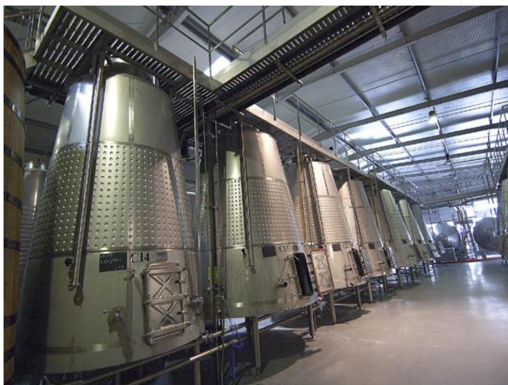
Figura 18 - Zona de vinificação e estabilização de vinhos, da Falua SA.
