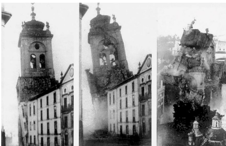
Figura 47. Demolição da Torre Sineira do Mosteiro de Santa Cruz de Coimbra. Data: 3 de janeiro de 1935.
