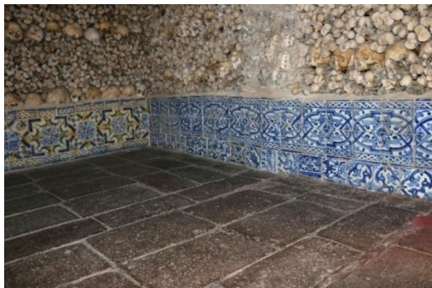
Figura 82. Azulejos do muro oeste e norte da Casa dos Ossos de Évora.
