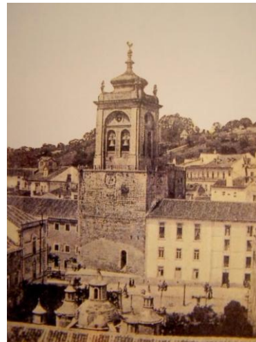
Figura 46. Torre Sineira antes da sua demolição em 1935.
