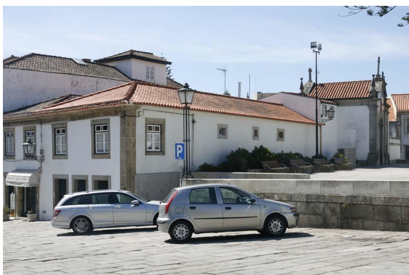
Fig. 107 – Casa manuelina no lado sul da Praça Nova .
