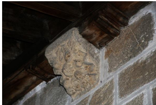
Figs. 14 e 15 – Teto da igreja, visto desde o coro alto; um dos poiais (com alfarge) onde apoia o teto.
