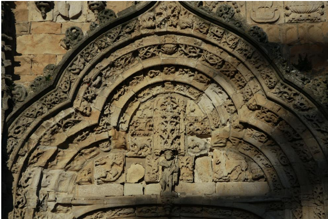
Fig. 33 – Pormenor do portal.
