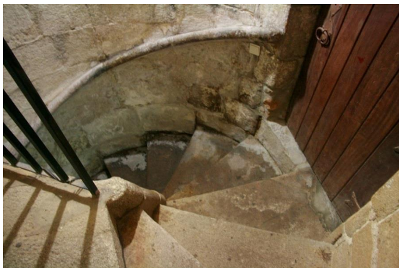
Fig. 27 – Final da escada em caracol, acedendo-se ao coro alto pelo lado esquerdo e à torre sineira pela porta à direita.
