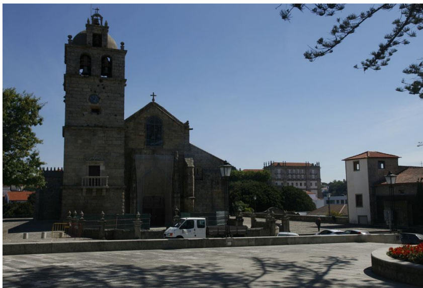
Fig. 106 – Vista para a igreja matriz desde a Praça Nova .
