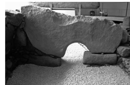
Fig. 4b. Idem. Aspeto de parte do edifício depois de musealizado.
