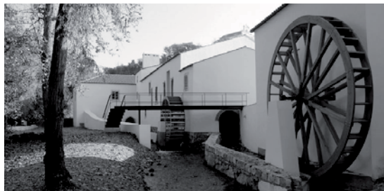
Figura. 2 – Alzado Nordeste del Molino del Papel de Leiria después de las obras de rehabilitación concluidas en 2009. Fuente: Cámara Municipal de Leiria en Folleto del Museo Molino del Papel.
