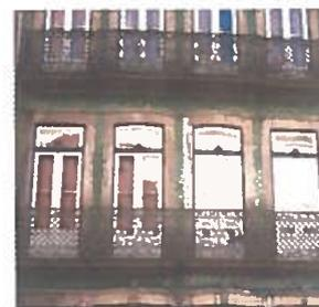
Fig. 11 - Sacadas apoiadas integralmente na espessura da parede da fachada, na casa n.ºs 77-79, no Largo de S. Domingos.
