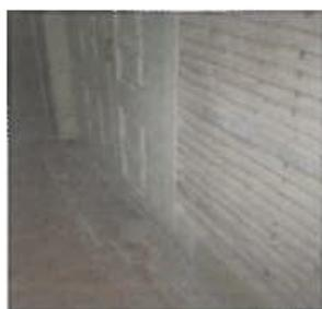
Fig. 32 – Revestimento de fasquiado de uma parede de tabique interior da casa n.º 135-145.
