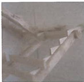
Fig. 43 – Maqueta da estrutura de uma escada de dois lanços.
