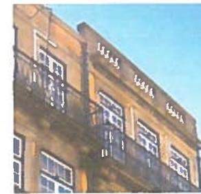
Fig. 20 – Platibanda opaca e platibanda com balaústres pertencentes às casas n.º 78-82 e n.º 72-76, respectivamente.
