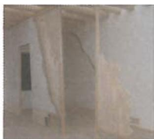
Fig. 31 – Maqueta de uma parede interior de tabique.
