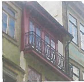
Fig. 28 – Parede de piso recuado parcialmente em madeira da casa n.º 304-306.
