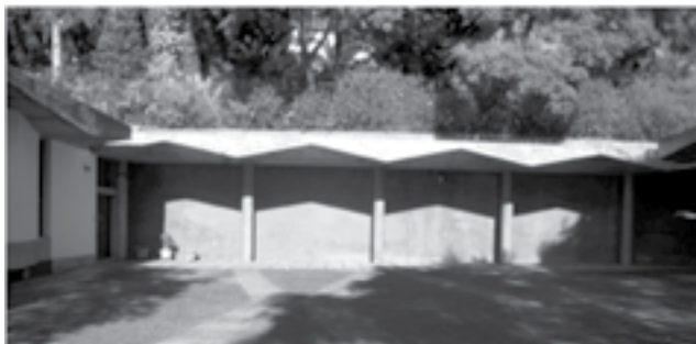
16. Vista da galeria exterior do adro
