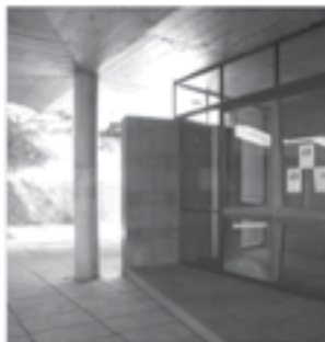
15. Vista da entrada
