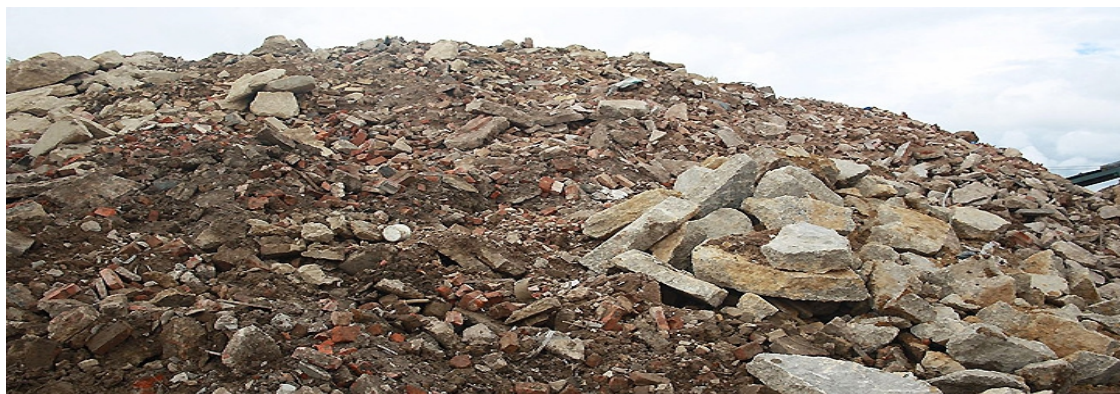
Figura 1 – Resíduos de Construção e Demolição (RCD) [5].
