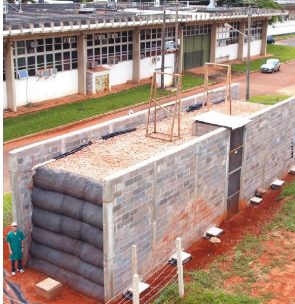
Figura 5 - Muros de solos reforçados construídos com RCD-R (Santos, 2011)
