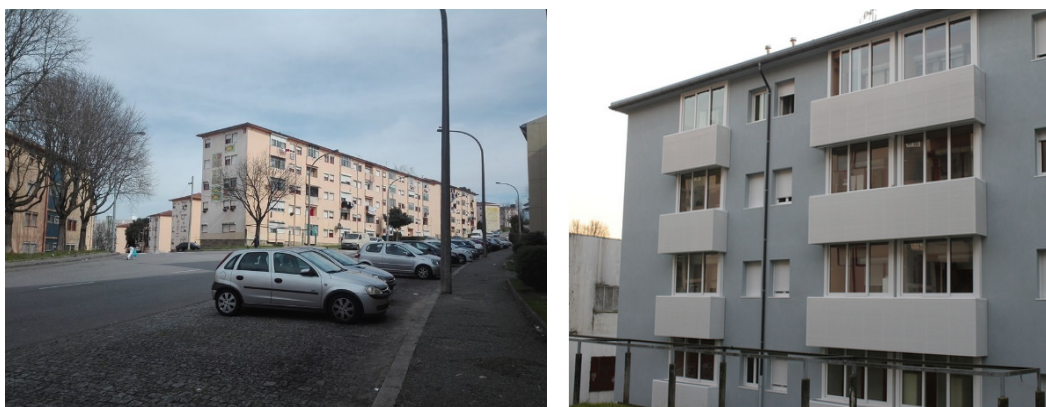
Figura 3 Evolução das fachadas do Bairro do Cerco do Porto. Do lado esquerdo temos as fachadas do Bairro em 2018 e do lado direito, em 2019/2020 o resultado final com a última reabilitação
