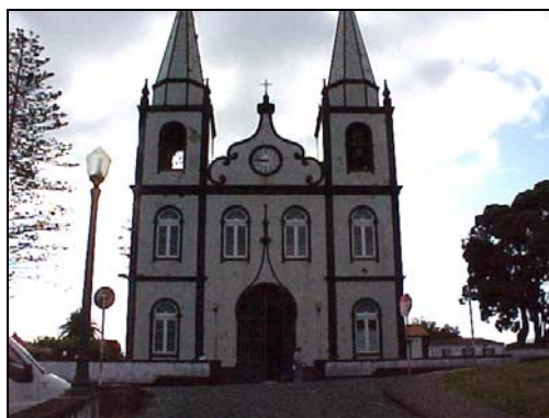
Fig. 1 – Vista geral da Igreja da Madalena
