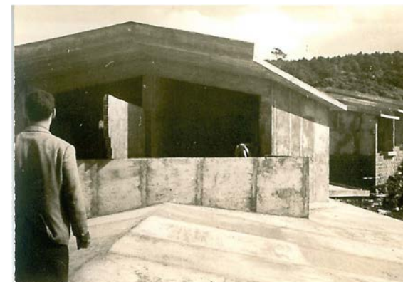
[26]; [27]; Vista na cobertura; Vista para o restaurante;
