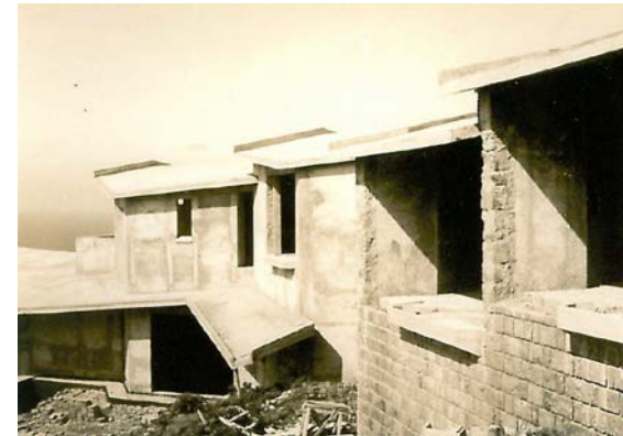
[22]; [23]; Vistas dos volumes dos quartos, em construção;
