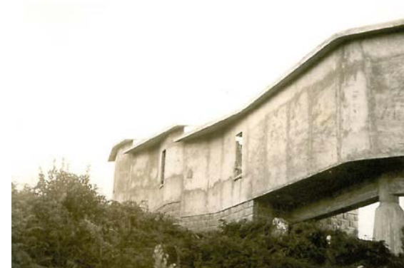
[24]; [25]; Vistas do volume da ponte, pilar;
