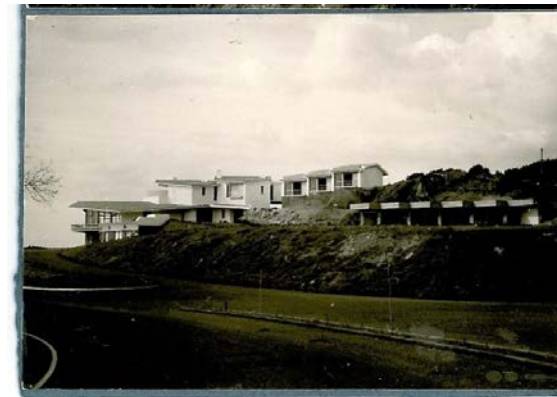
[47] Vista da Estrada, obras terminadas, 1969;
