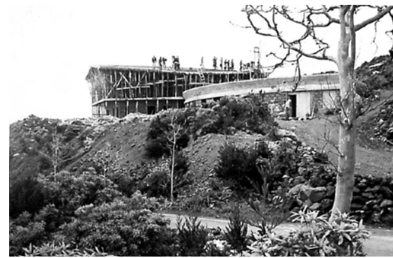
[16]; [17]; [18]; [19]; Andamento das obras, s/data.
