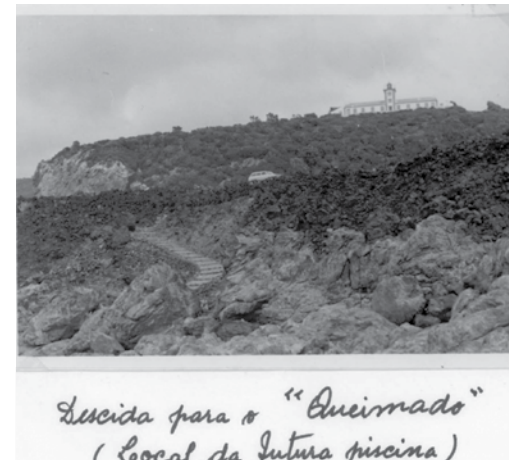
[37] Vista do terreno para construção da piscina;
