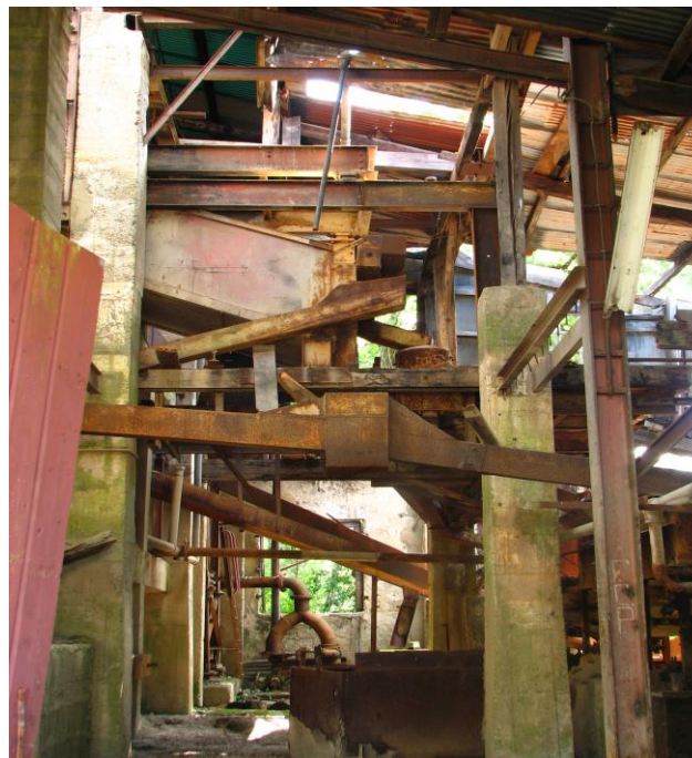
Foto 9: vista da entrada norte da Lavaria Nova. Em primeiro plano canal de escoamento de água.
