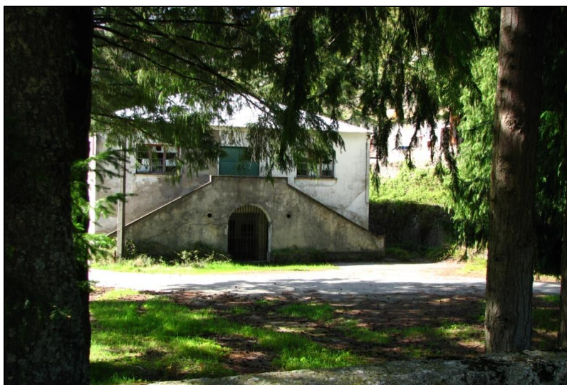
Foto 2: Atual estado do edifício dos escritórios (construído em 1941).
