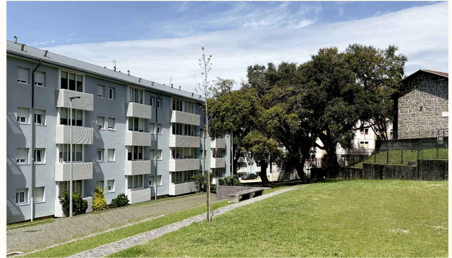
Bairro do Cerco do Porto após o processo de intervenção, 2023 | Cerco do Porto neighbourhood after the intervention process, 2023. © Luciana Rocha
