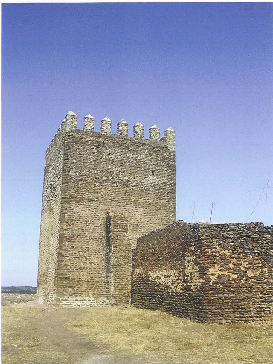
Fotografia 6 - Torre de Menagem do castelo de Noudar
